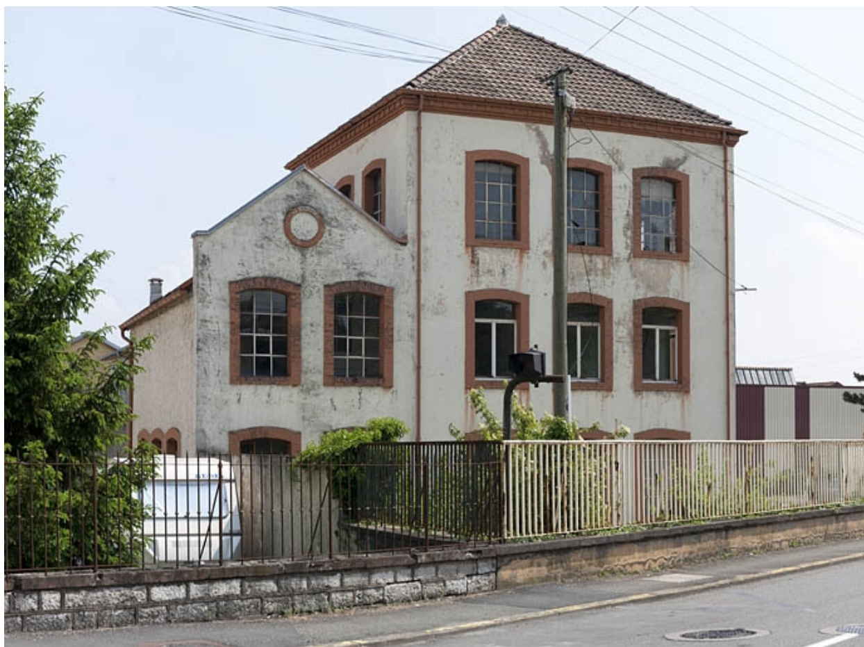
Façade sur rue du bâtiment d'entrée.
