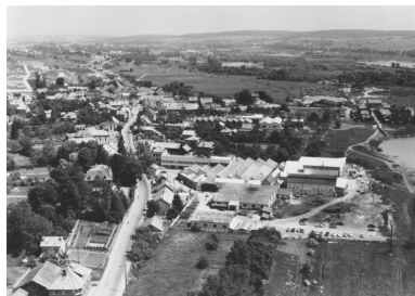
Vue aérienne de l'usine depuis le sud. Phot. Raphaël Favereaux, Autr. Roger Henrard IVR43_20122501570NUC2
