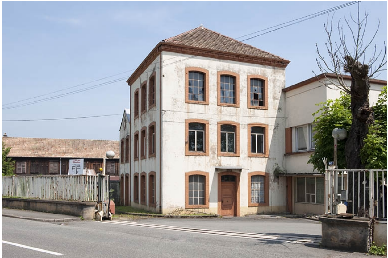
Bâtiment d'entrée vu de trois quarts.
