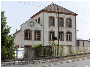
Façade sur rue du bâtiment d'entrée. Phot. Jérôme Mongreville IVR43_20122501109NUC4A
