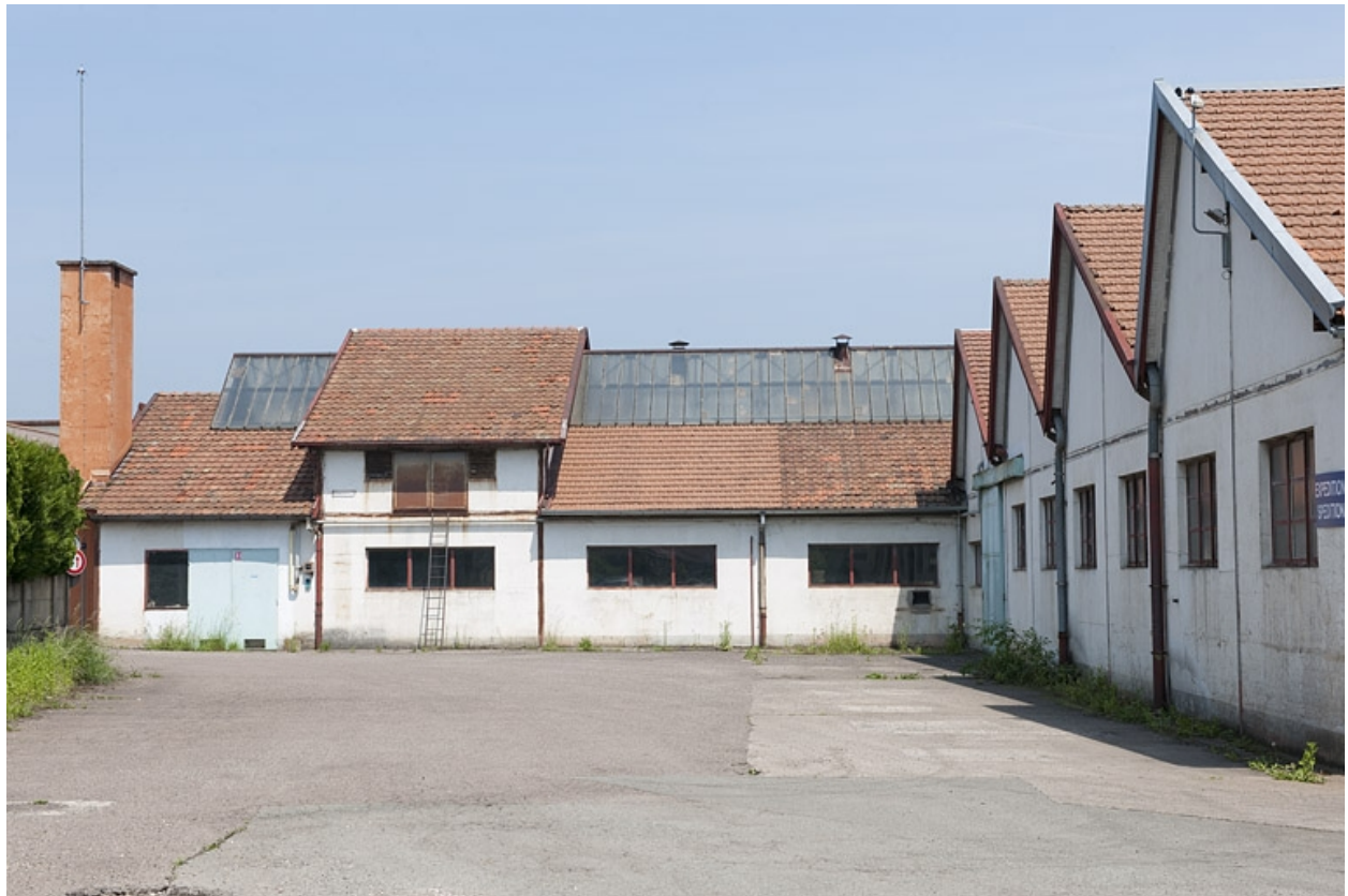
Façade et pignons d'ateliers de fabrication.
