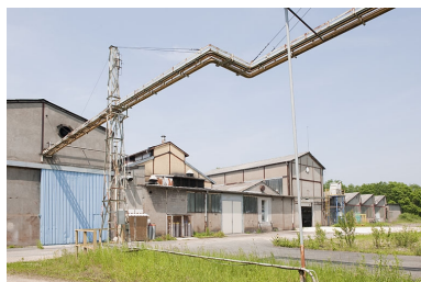
Pignons des bâtiments industriels depuis le sud. Phot. Jérôme Mongreville IVR43_20122501119NUC4A
