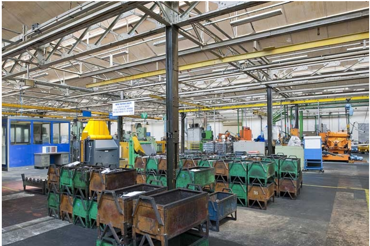
Atelier d'usinage nord.
