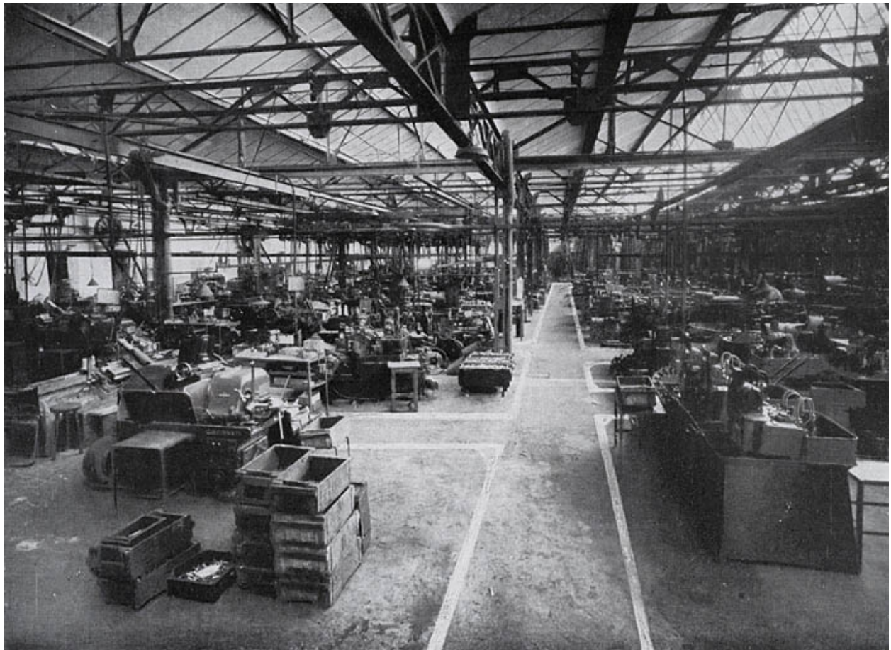
Vue d'ensemble de l'atelier principal. Photogr., s.n., s.d. [1949].
