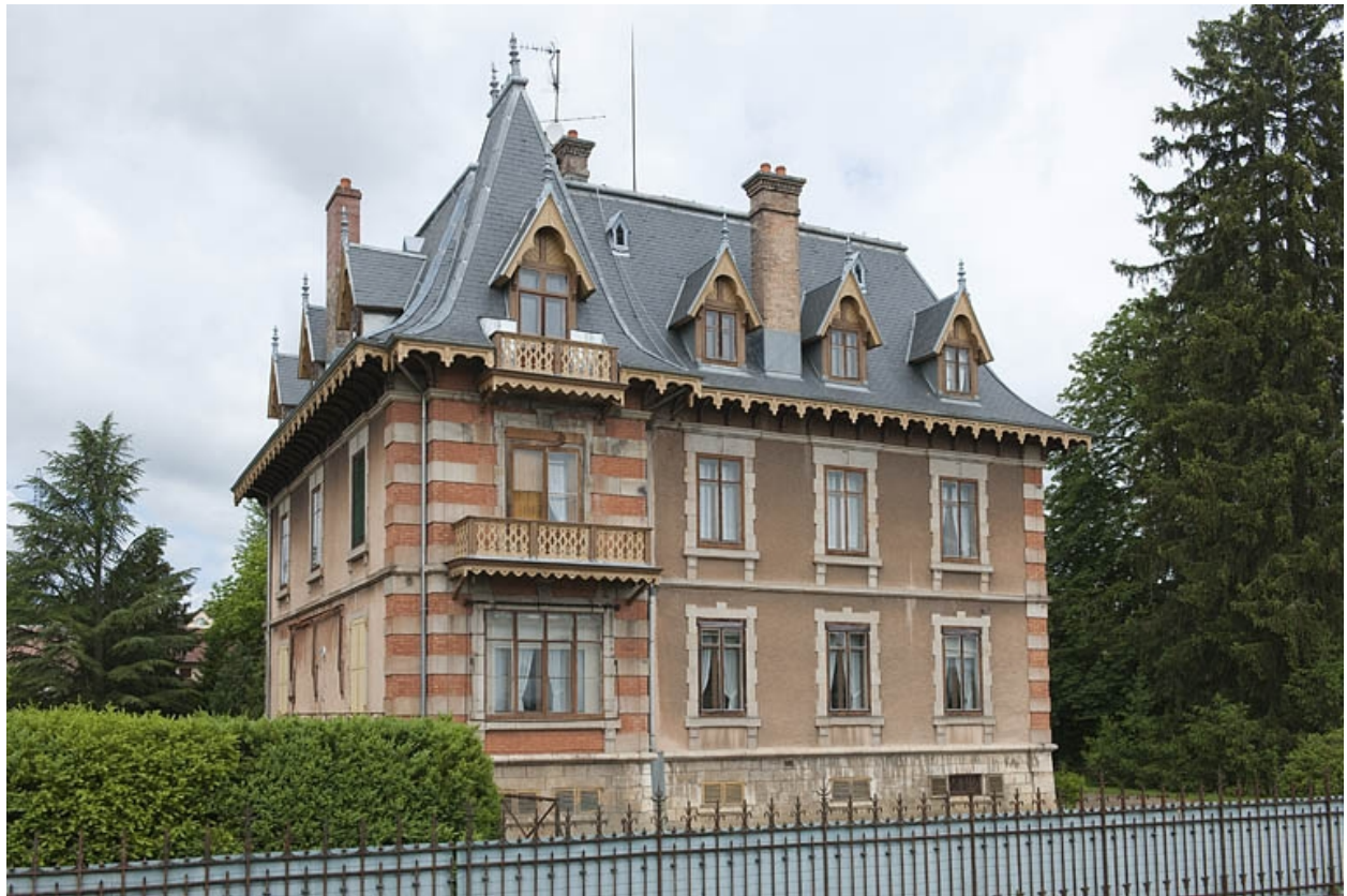
Logement patronal. Façade orientale.
