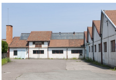
Façade et pignons d'ateliers de fabrication. Phot. Jérôme Mongreville IVR43_20122501117NUC4A
