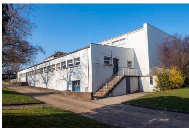
Façade nord-est du gymnase de garçons. Phot. Mary Ruffinoni IVR43_20142500044NUC4A
