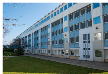
Façade postérieure de l'externat. Phot. Mary Ruffinoni IVR43_20142500039NUC4A
