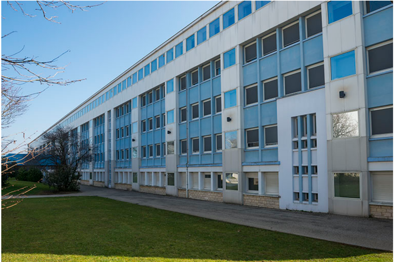
Façade postérieure de l'externat.
