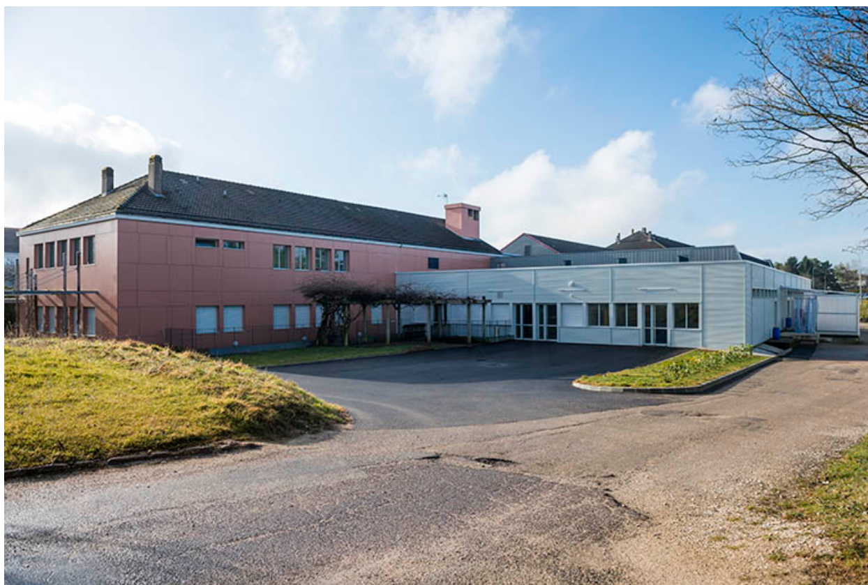
Vue de trois-quart des services communs.
