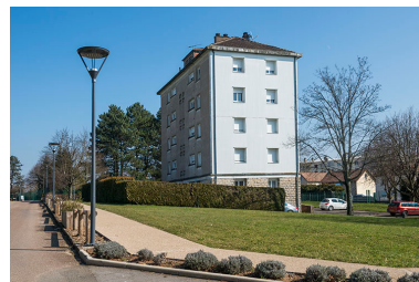
Logements est de fonction. Phot. Mary Ruffinoni IVR43_20142500042NUC4A
