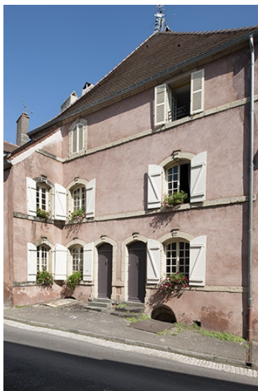
Vue générale de la façade postérieure rue Thiers. Phot. Jérôme Mongreville IVR43_20127000428NUC4A
