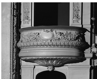
Salle, détail : balcon d'avant-scène. Phot. Yves Sancey IVR43_19833900441X
