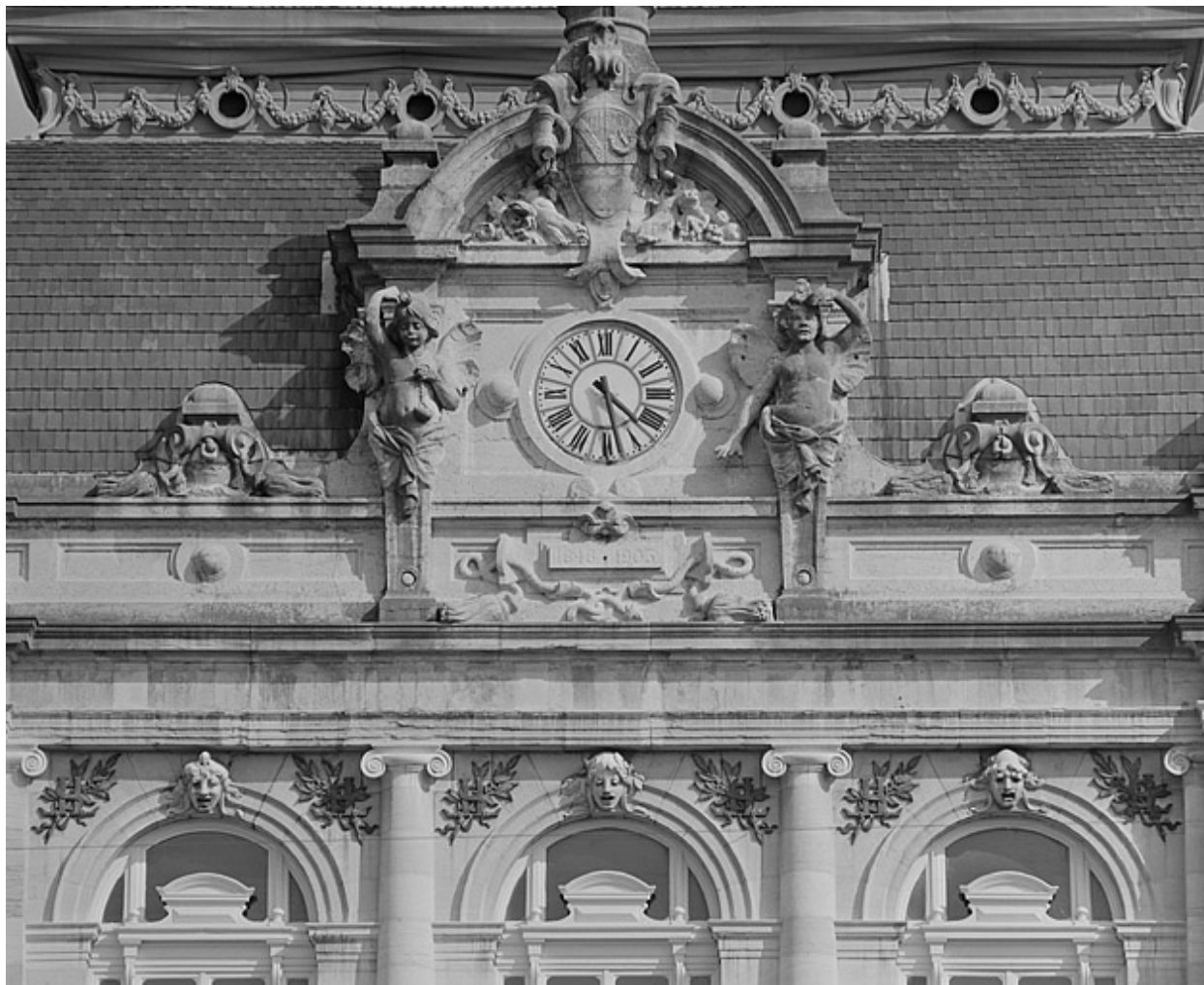
Façade antérieure, le couronnement.
