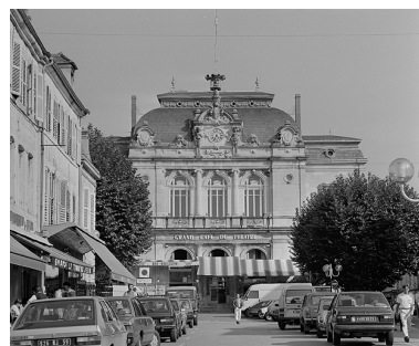
Façade antérieure, vue générale. Phot. Yves Sancey
