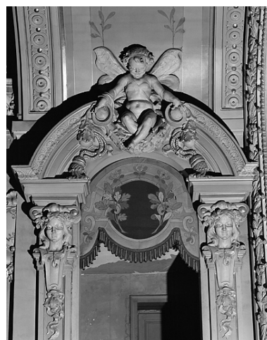
Salle, détail : couronnement des loges d'avant-scène. Phot. Yves Sancey IVR43_19833900439X
