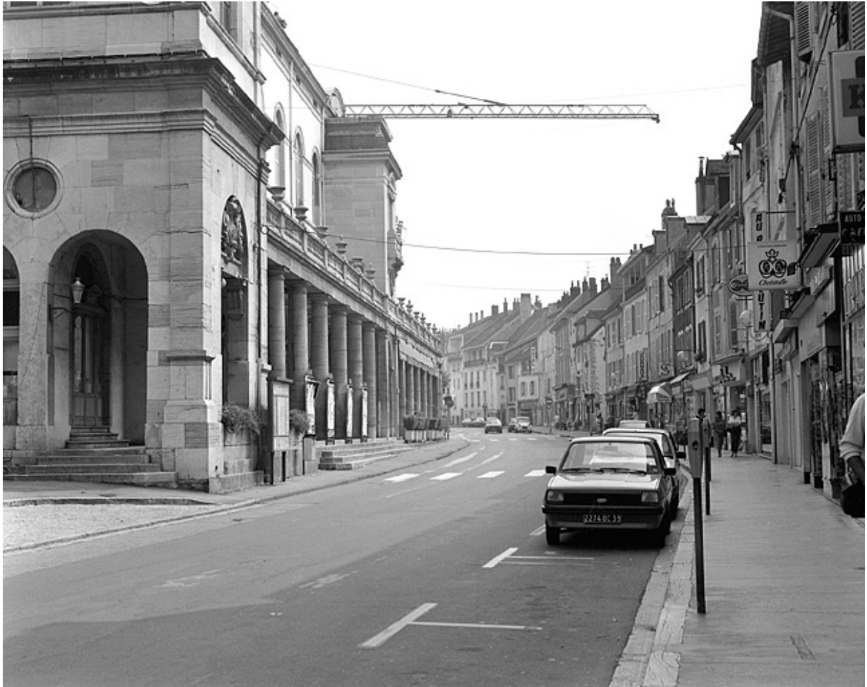
Façade latérale droite.
