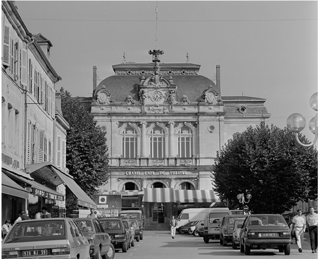
Façade antérieure, vue générale.
