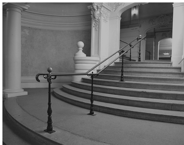
Grand escalier : détail.
