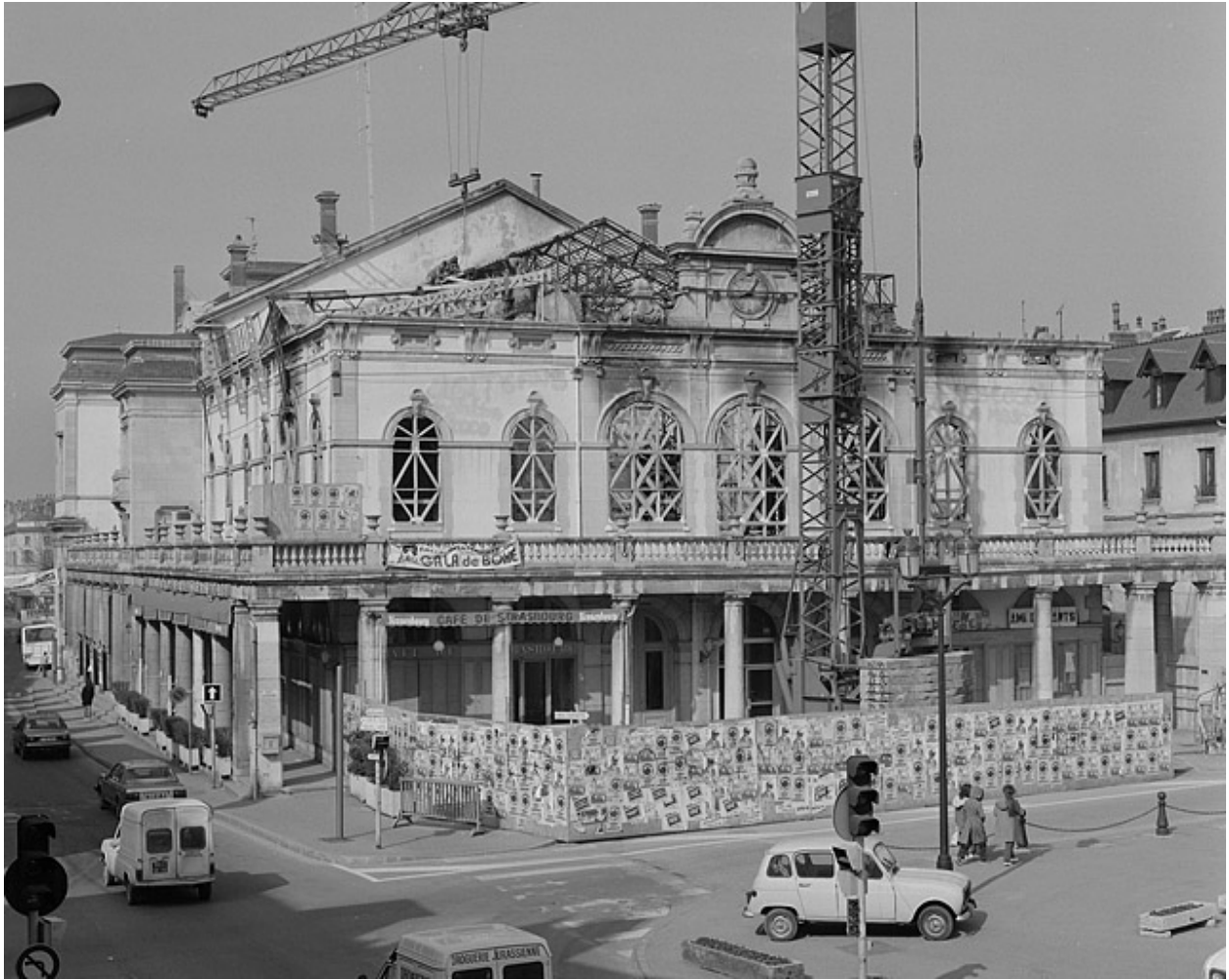
Façade postérieure (après l'incendie de 1983).
