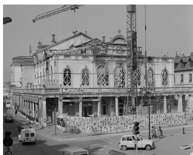
Façade postérieure (après l'incendie de 1983).
