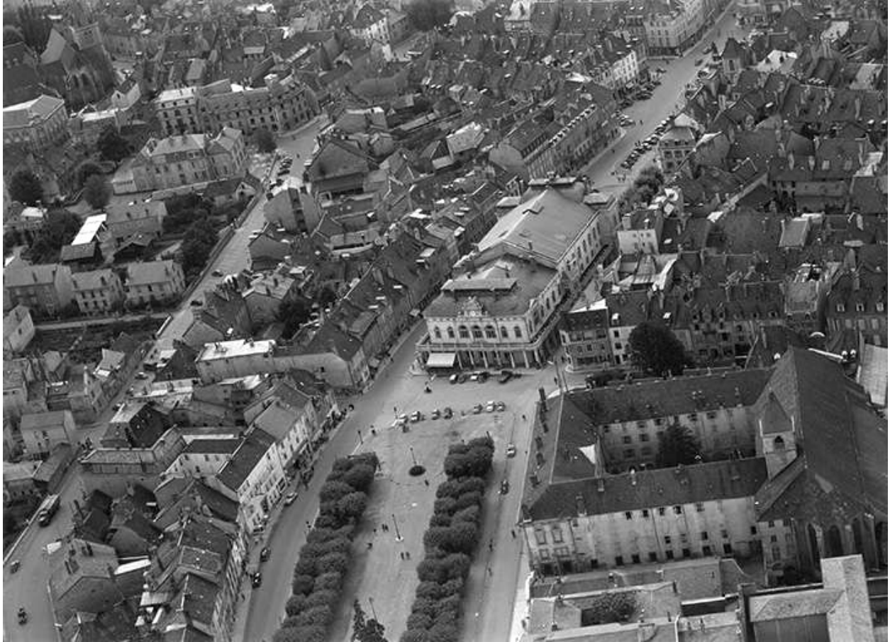
Vue aérienne en 1956 avec le couvent des cordeliers au premier plan.
