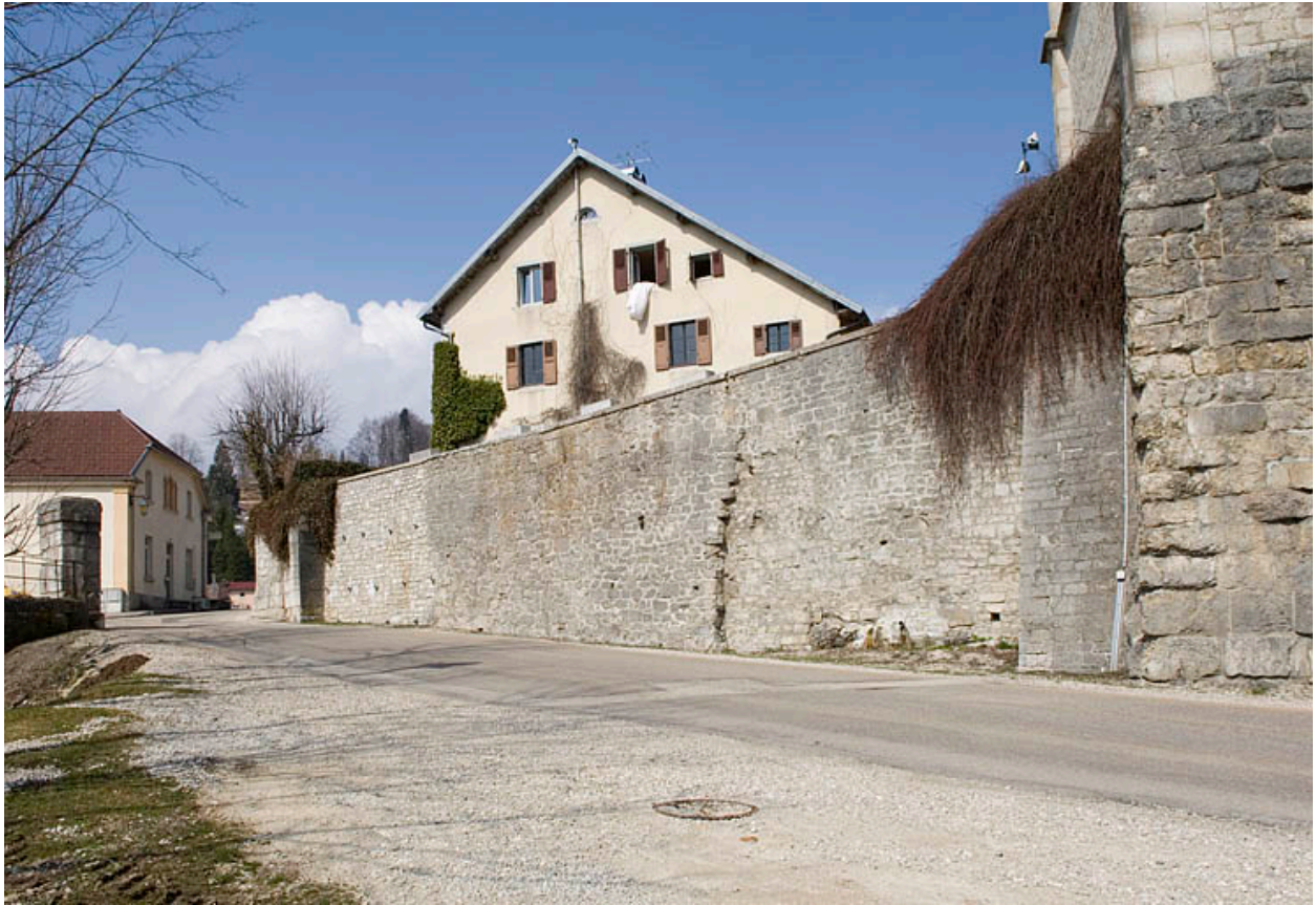
Porte sud et reprise moderne.
