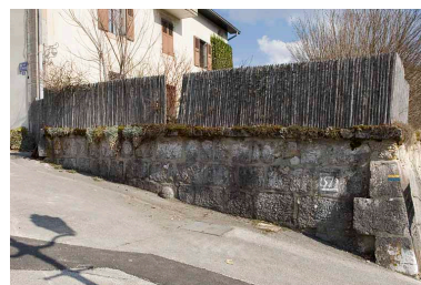
Enceinte au niveau de la maison Billet, rue de l'Eglise. Phot. Jérôme Mongreville IVR43_20092500762NUC2A
