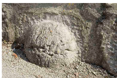
Enceinte au niveau de la maison Billet, détail du bossage. Phot. Jérôme Mongreville IVR43_20092500761NUC2A
