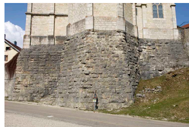
Mur de soutènement du chevet de l'église. Phot. Jérôme Mongreville IVR43_20092500744NUC2A
