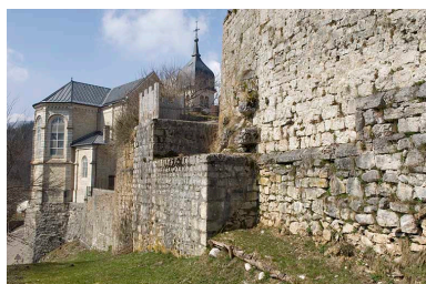
Enceinte est moderne et médiévale. Phot. Jérôme Mongreville IVR43_20092500747NUC2A
