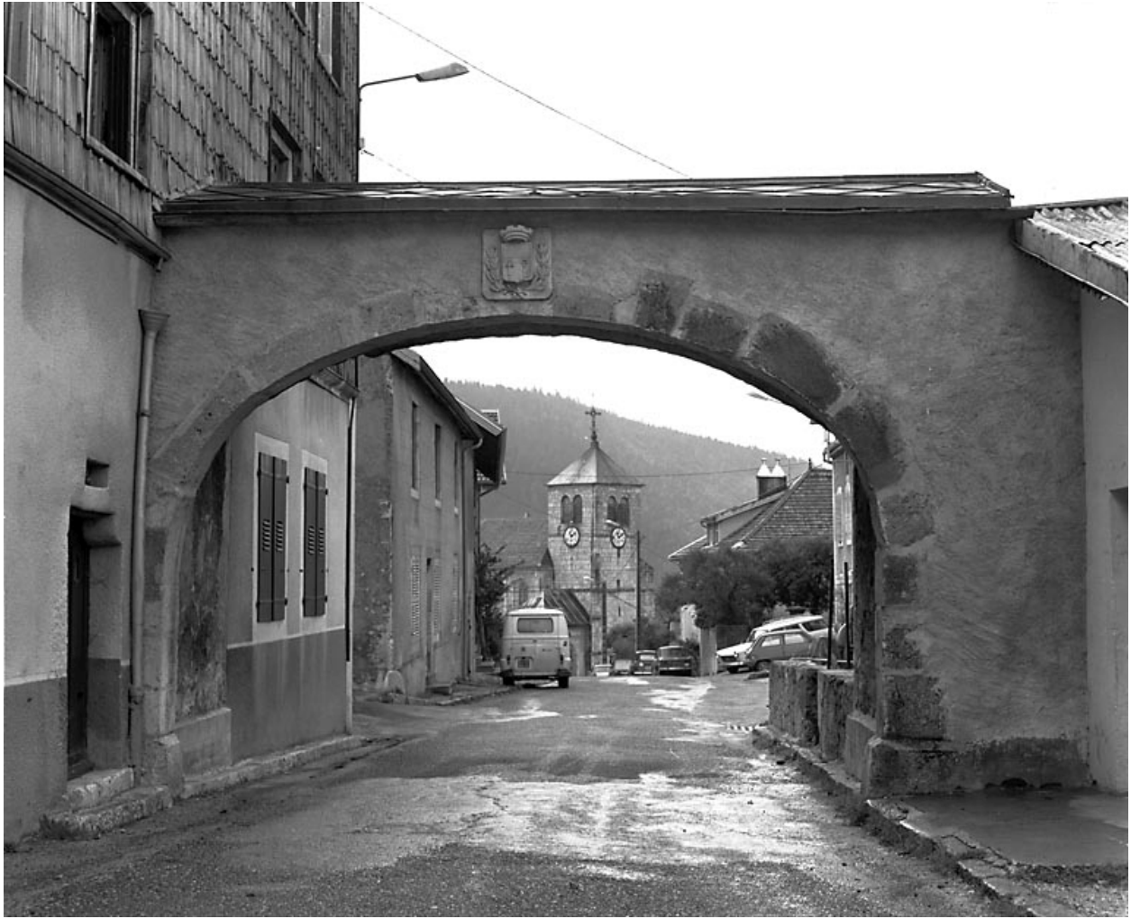
Vue rapprochée de la porte nord, côté faubourg, en 1978.
