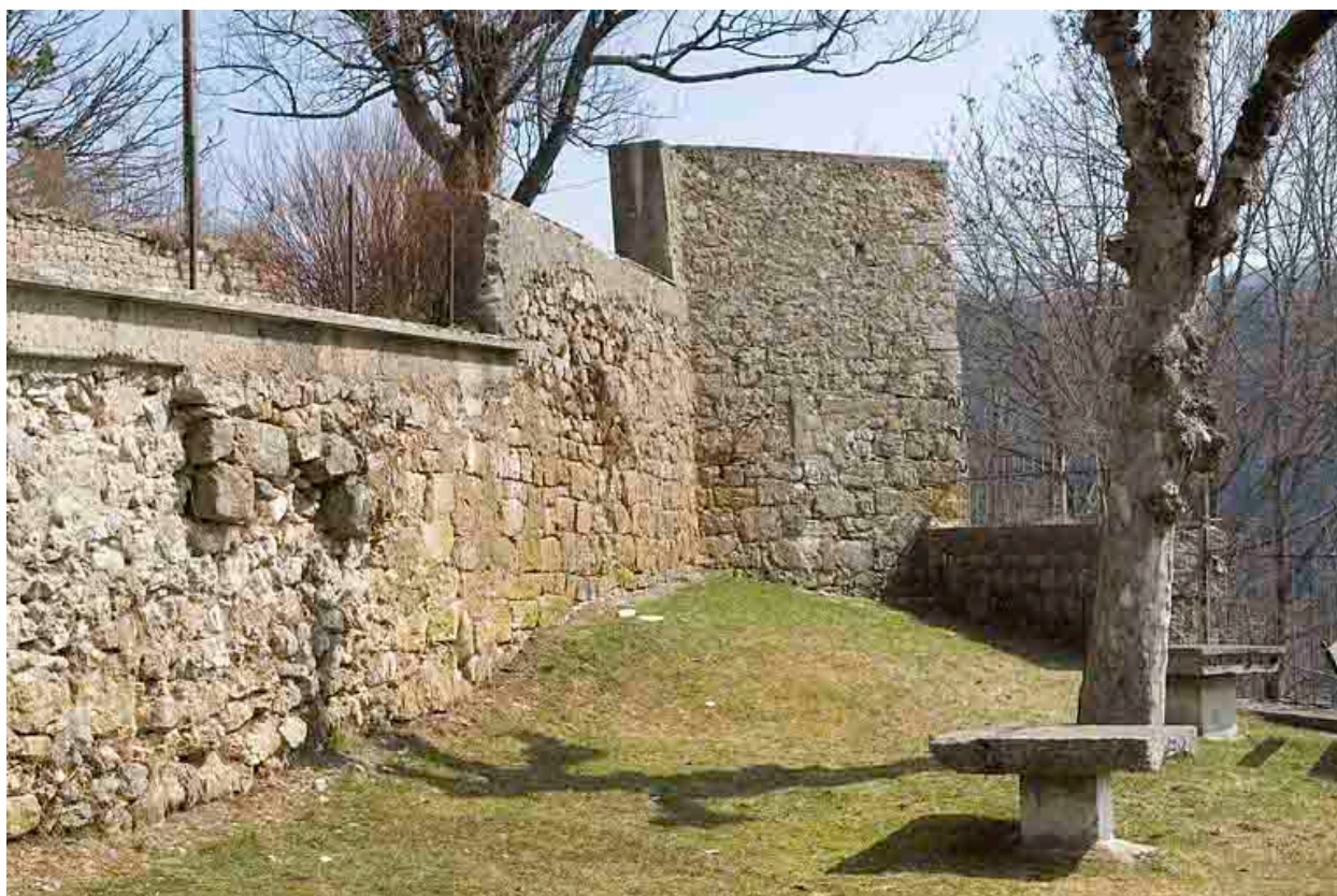
Mur entre l'église paroissiale et l'hôtel de la Couronne.
