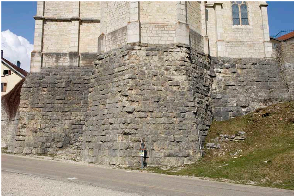
Mur de soutènement du chevet de l'église.
