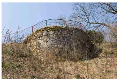
Enceinte médiévale est et tour. Phot. Jérôme Mongreville IVR43_20092500751NUC2A
