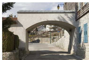
Vue rapprochée de la porte nord, côté village. Phot. Jérôme Mongreville IVR43_20092500764NUC2A
