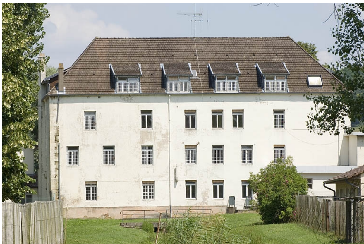
Façade postérieure depuis l'aval du bief.
