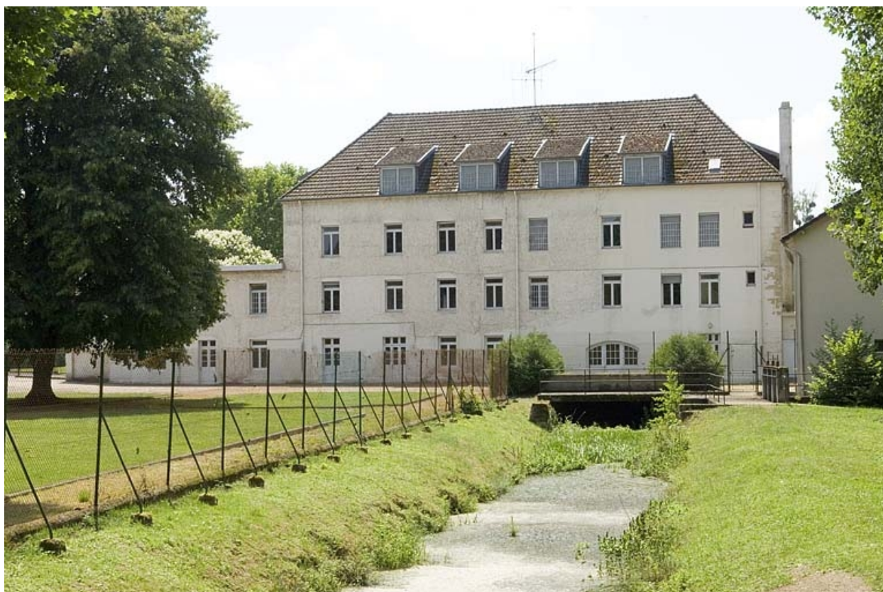
Façade antérieure depuis l'amont.
