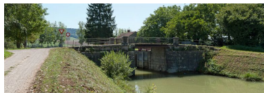
Vue du pont depuis l'amont. Phot. Pierre-Marie Barbe-Richaud IVR26_20112103918NUC4AQ
