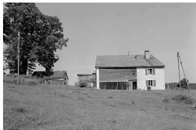
Vue générale avec le fournil. Phot. Jérôme Mongreville IVR43_19943900754X
