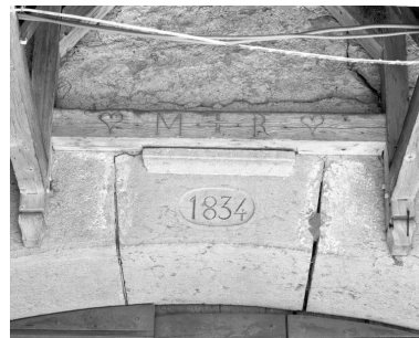
Le linteau de la porte d'entrée. Phot. Jérôme Mongreville IVR43_19943900756X
