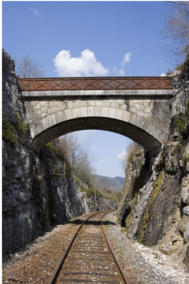
Vue d'ensemble, depuis la voie côté La Cluse (sud). Phot. Yves Sancey IVR43_20073900139NUCA
