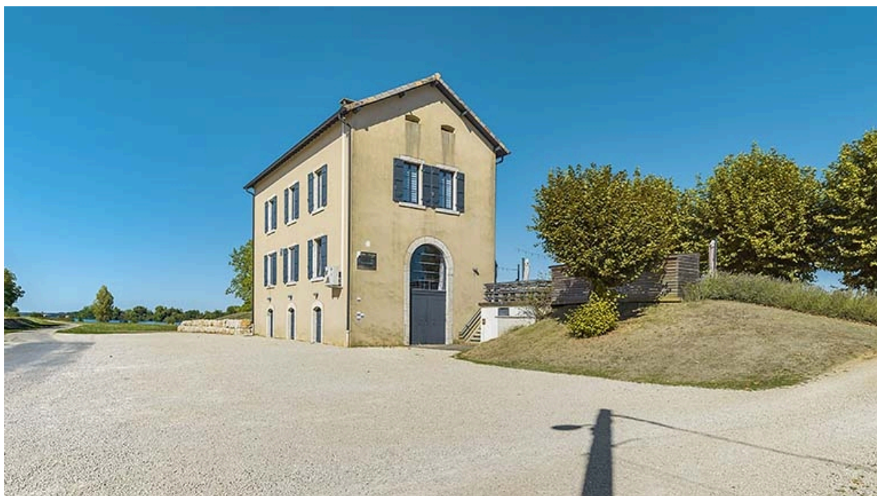
Pignon et façade postérieure de la maison.
