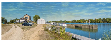
Vue d'ensemble du site de Gigny : ancienne écluse et maison, rive droite. Phot. Thierry Kuntz IVR26_20207100405NUC4A
