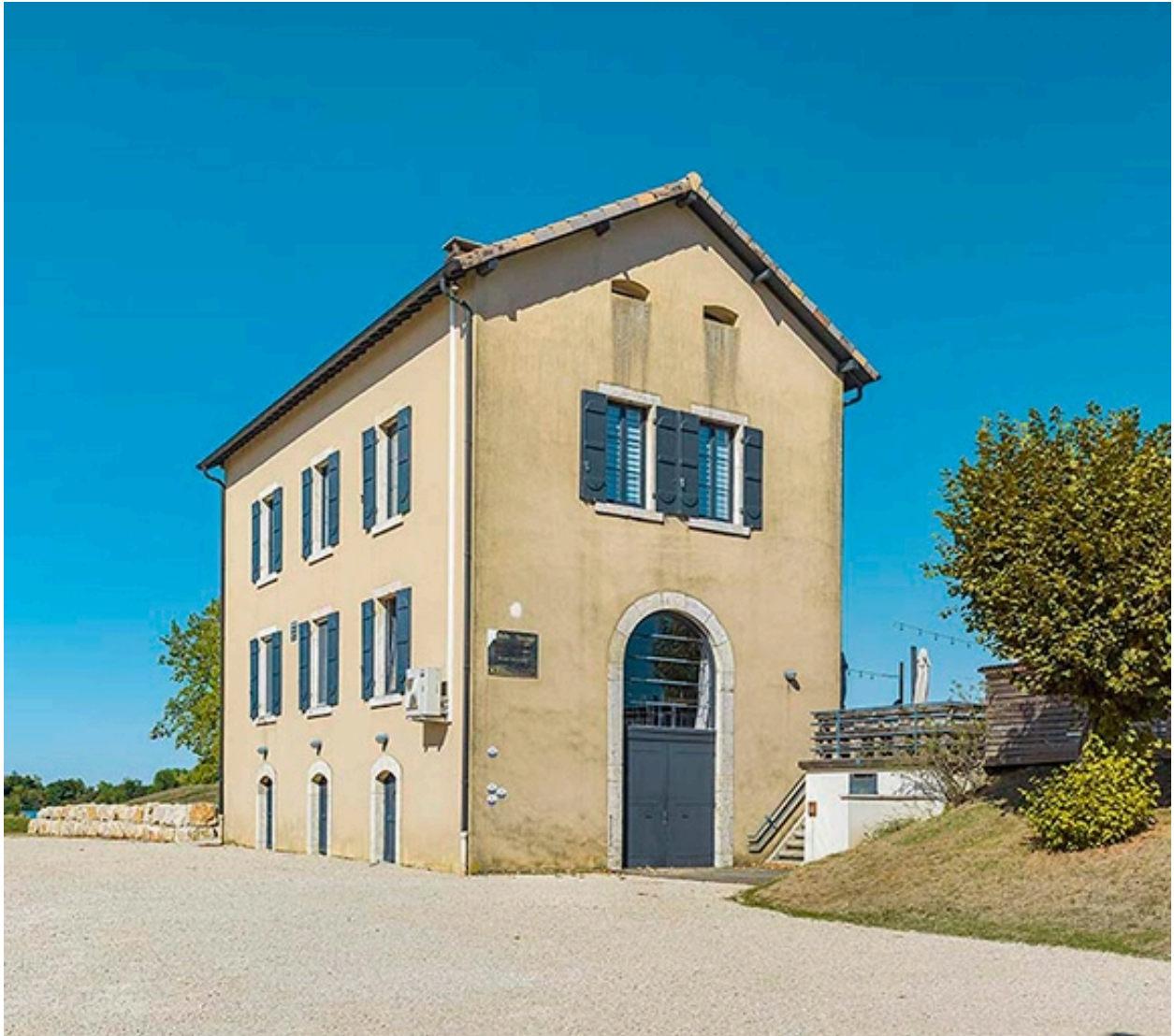
Pignon et façade postérieure de la maison.
