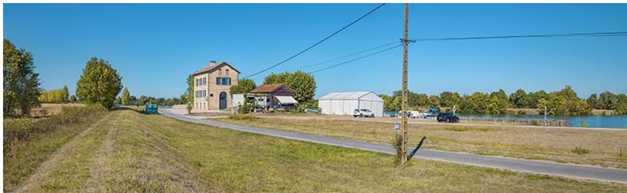
Vue d'ensemble du site et de la maison d'éclusier-barragiste.
