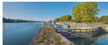
Le sas et les portes amont de l'ancienne écluse de Gigny. Phot. Thierry Kuntz IVR26_20207100403NUC4A
