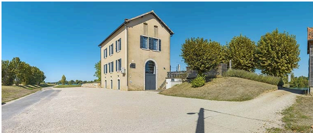
Pignon et façade postérieure de la maison.
