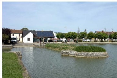
Cale à l'ouest du port, vue d'ensemble.
