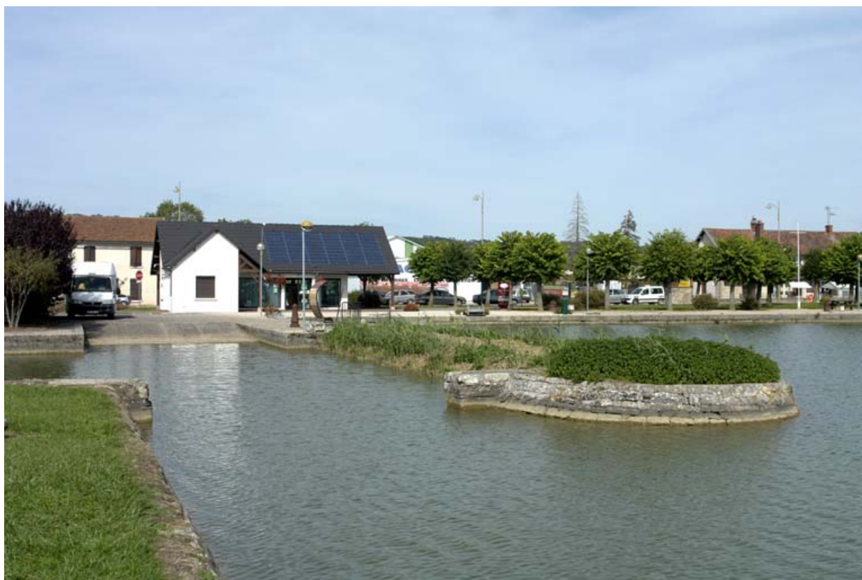
Cale à l'ouest du port, vue d'ensemble.
