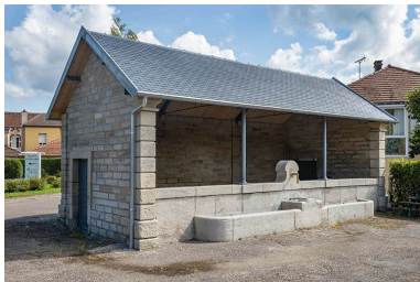
Lavoir de la gare : vue de trois quarts gauche. Phot. Jérôme Mongreville IVR43_20217000502NUC4A
