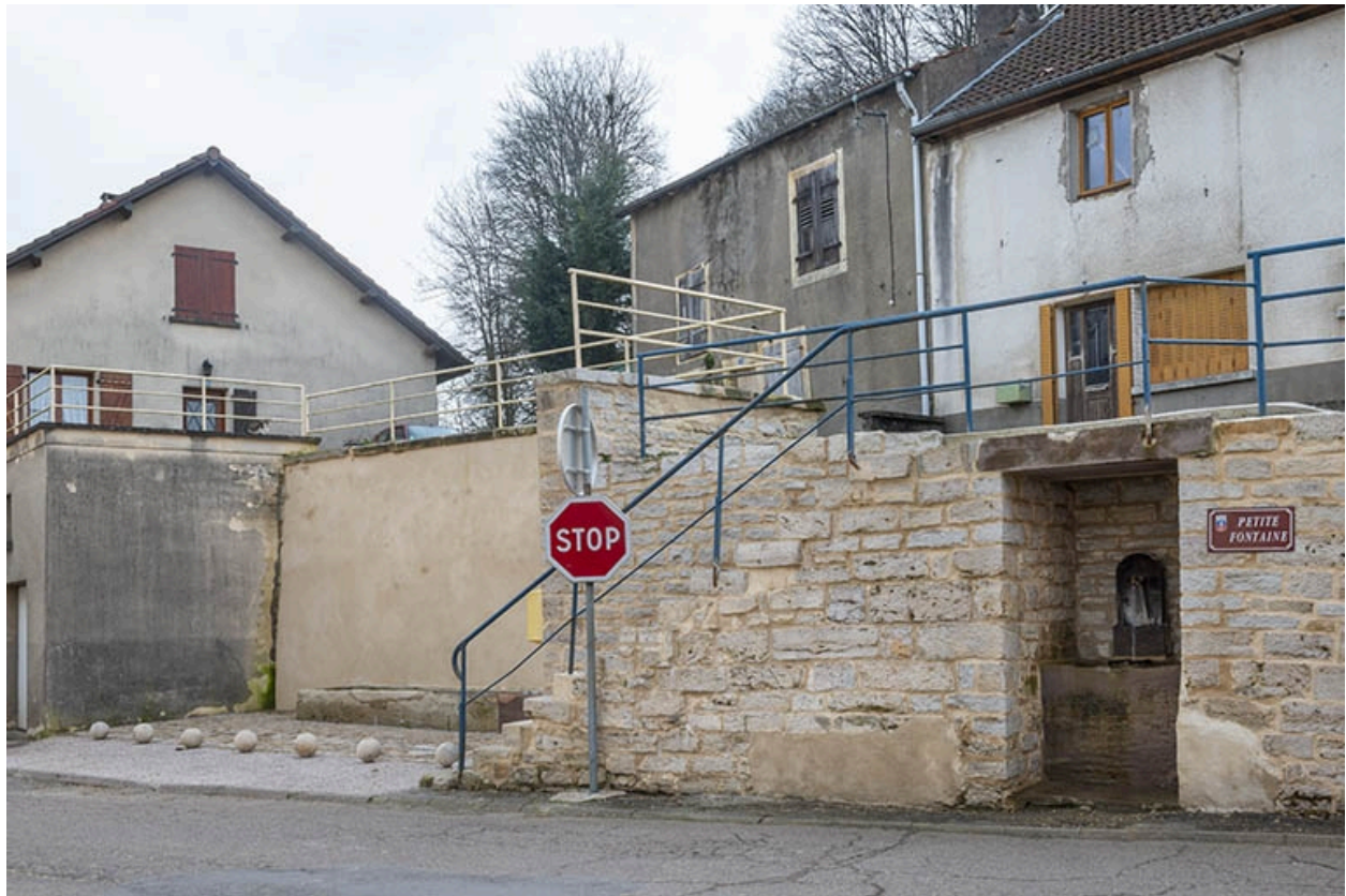
Fontaine dite Petite Fontaine et abreuvoir, à hauteur du n° 74 rue Adolphe-Thiers.
