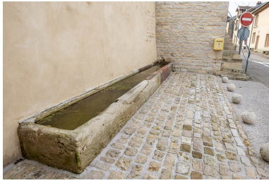
Abreuvoir, à hauteur du n° 74 rue Adolphe-Thiers. Phot. Jérôme Mongreville IVR43_20227000055NUC4A
