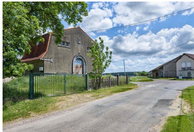
Le bâtiment des eaux de la rue du Bac, de trois quarts gauche, dans l'environnement. Phot. Jérôme Mongreville IVR43_20217000322NUC4A
