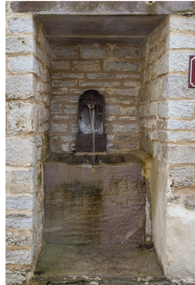
Fontaine dite Petite Fontaine, à hauteur du n° 74 rue Adolphe-Thiers. Phot. Jérôme Mongreville IVR43_20227000053NUC4A
