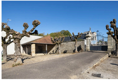
Le lavoir jouxtant le cimetière. Phot. Jérôme Mongreville IVR43_20217000661NUC4A
