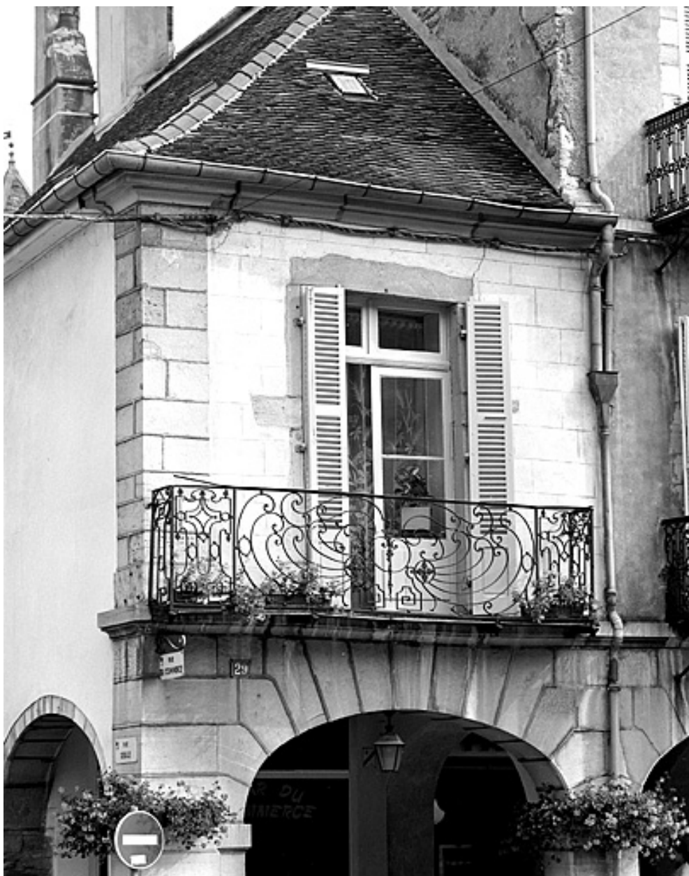
Façade antérieure, balcon.
