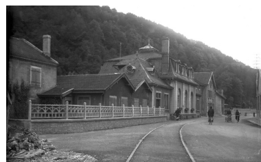
Le cercle de Beaulieu. Photogr., s.d. [début du 20e siècle]. Phot. Raphaël Favereaux, Autr. Mayer (photographe) IVR43_20122501504NUC2
