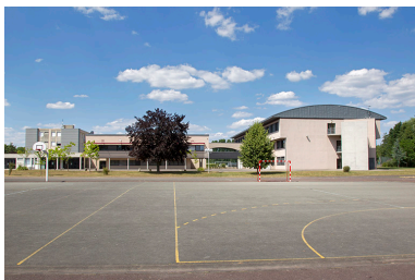
Terrain de sport et fa ades et pignon sud des externats. Phot. Sonia Dourlot IVR43_20147000211NUC2A
