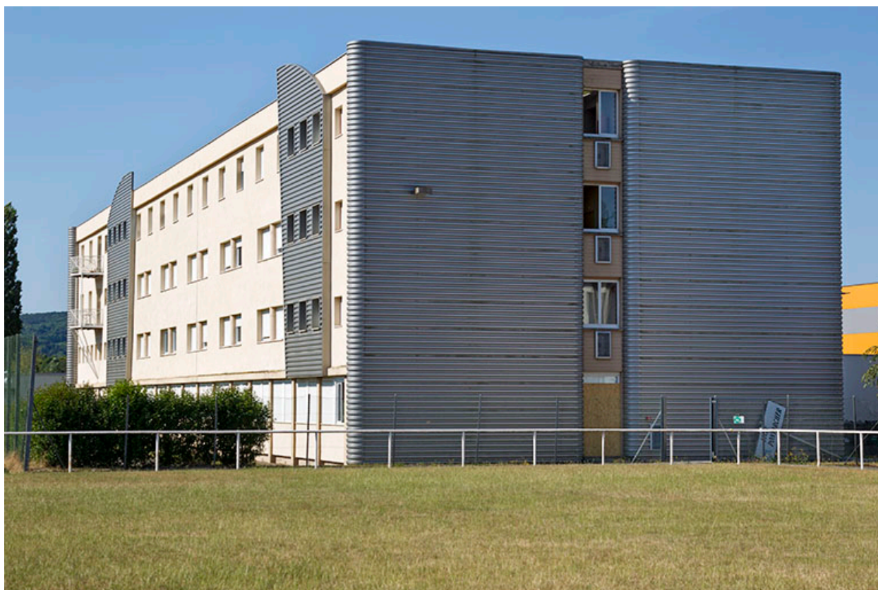
Pignon nord de l'internat.
