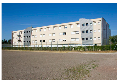
Fa ade est et pignon nord de l'internat.
