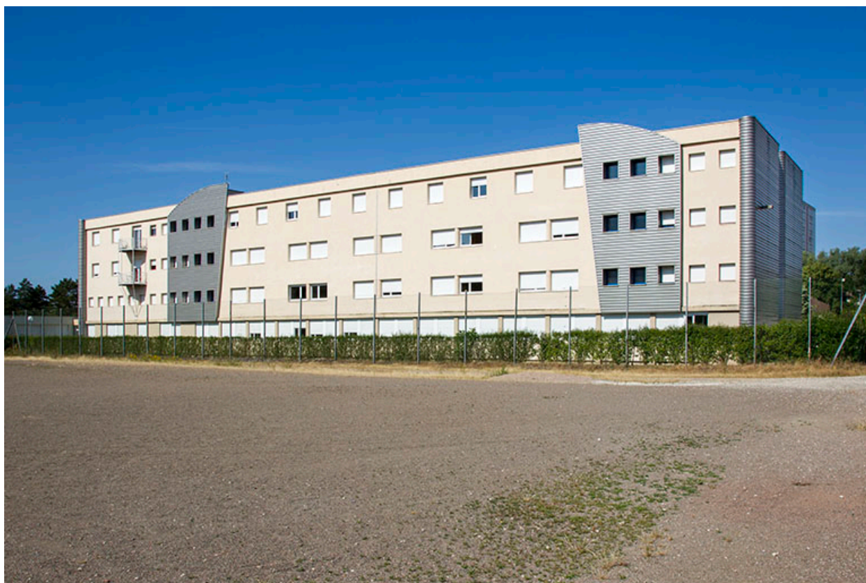
Fa ade est et pignon nord de l'internat.
