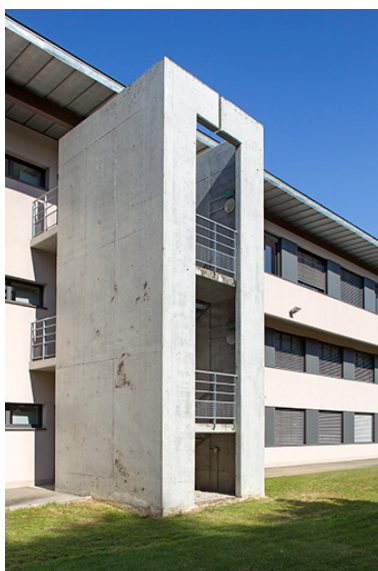
D tail de l'escalier de secours sur la fa ade post rieure de l'externat est, vu du sud-est. Phot. Sonia Dourlot IVR43_20147000214NUC2A
