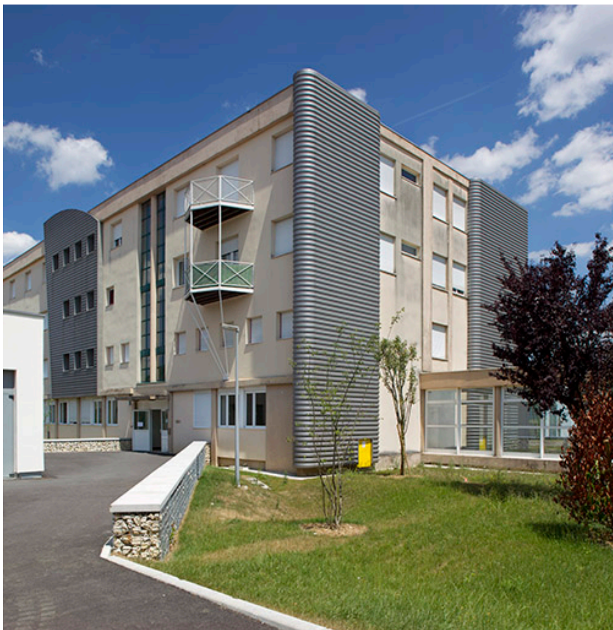
Angle sud-ouest, pignon sud de l'internat.
