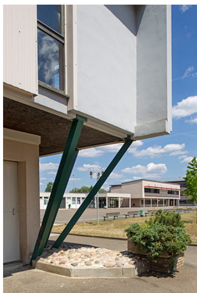
D tail de l'angle sud-est de la cantine. Phot. Sonia Dourlot IVR43_20147000222NUC2A
