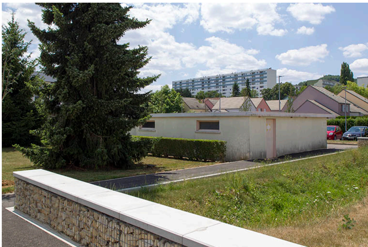
Fa ade post rieure est et pignon nord du local   v lo et garages.
