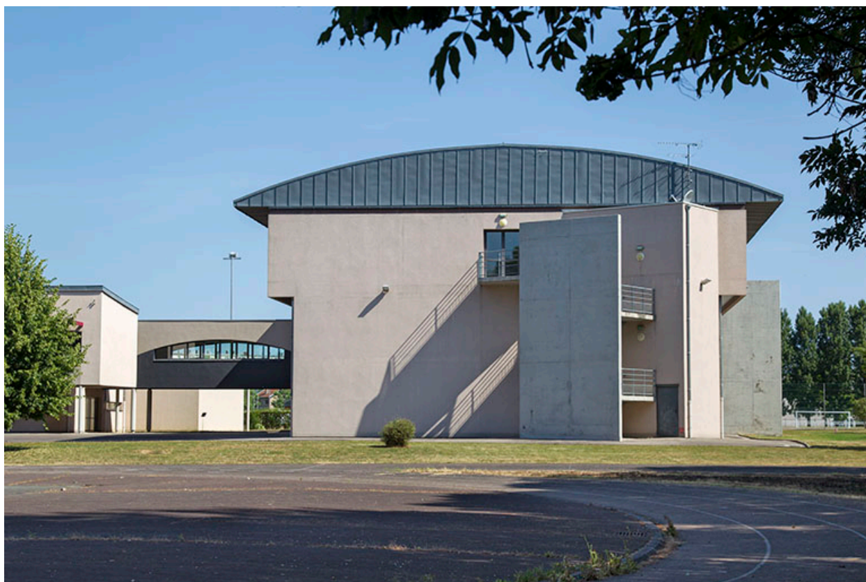
Pignon sud de l'externat est.
