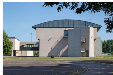
Pignon sud de l'externat est. Phot. Sonia Dourlot IVR43_20147000210NUC2A
