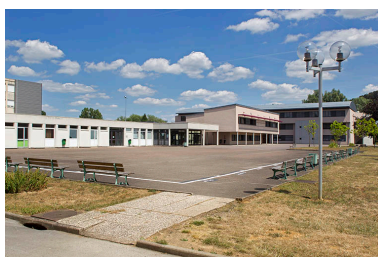
La cour vue du sud-ouest. Phot. Sonia Dourlot IVR43_20147000198NUC2A
