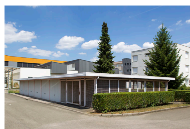
Vue d'ensemble depuis l'angle sud- ouest du local   v lo et garages. Phot. Sonia Dourlot IVR43_20147000226NUC2A
