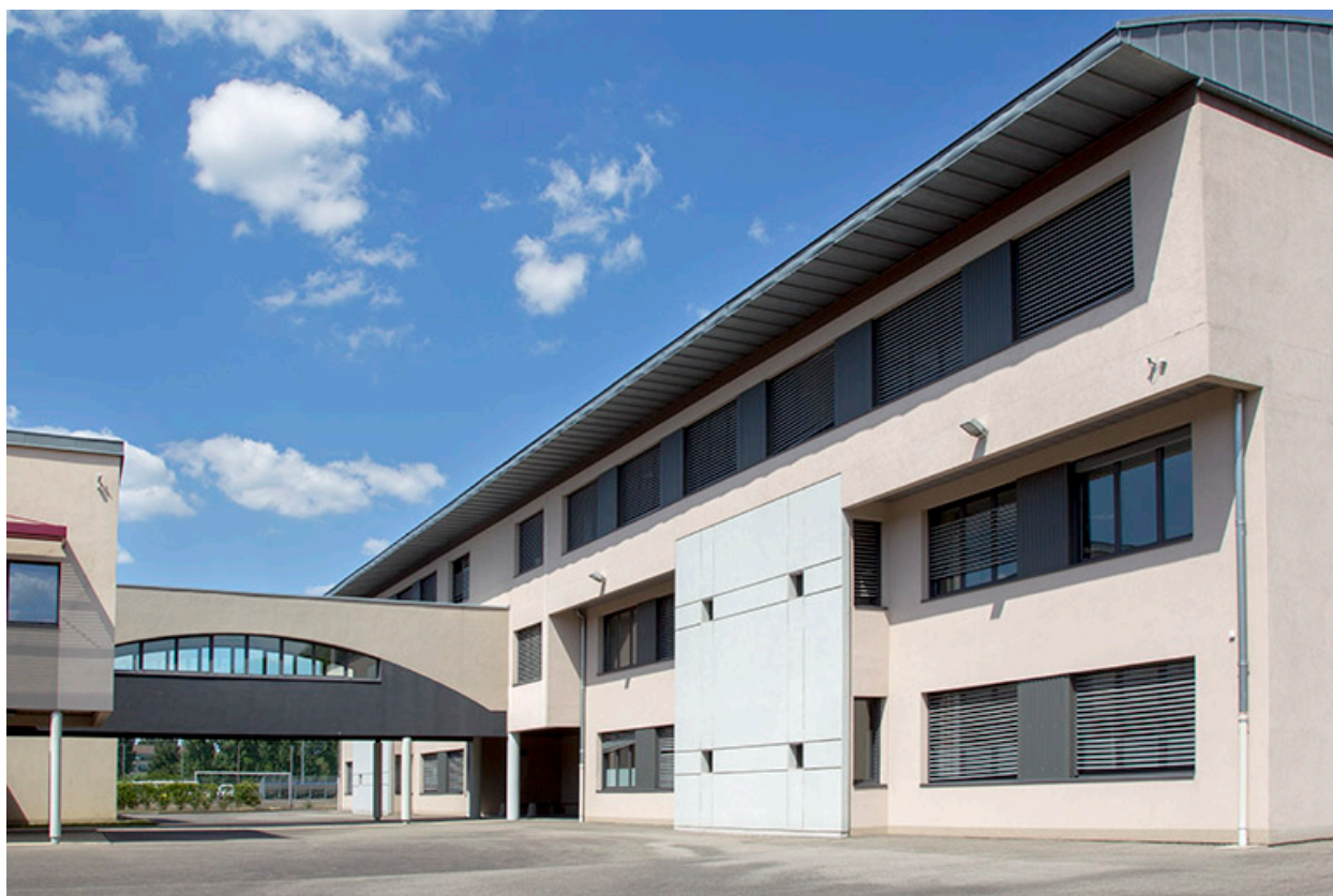
Vue de trois-quart sud-ouest de la fa ade ant rieure de l'externat est et sa liaison a rienne.
