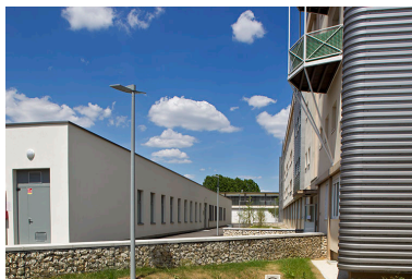
Fa ade est du p le h telier, vue de trois-quart sud-est. Phot. Sonia Dourlot IVR43_20147000178NUC2A
