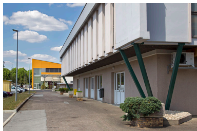
Angle sud-ouest de la cantine, les entr es et sorties sur la fa ade ouest. Phot. Sonia Dourlot IVR43_20147000224NUC2A
