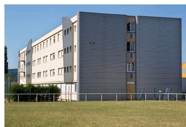
Pignon nord de l'internat.
