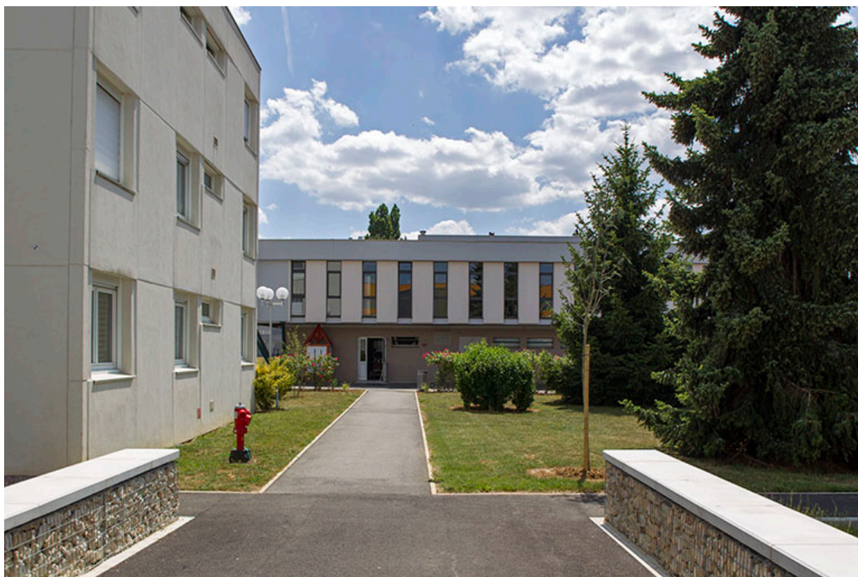
D tail de la fa ade nord de la cantine, vue depuis le long du pignon ouest des logements.
