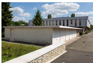
Vue d'ensemble des fa ades ouest du local   v lo et garages et de la cantine. Phot. Sonia Dourlot IVR43_20147000228NUC2A
