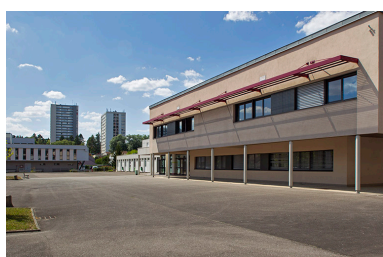
La cour vue de l'est. Phot. Sonia Dourlot IVR43_20147000199NUC2A
