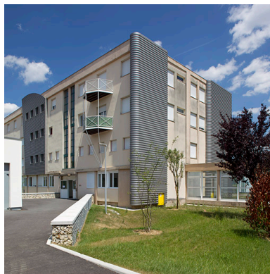
Angle sud-ouest, pignon sud de l'internat.
