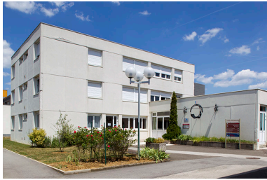
Entr e de l'ancien restaurant p dagogique et logements. Phot. Sonia Dourlot IVR43_20147000193NUC2A
