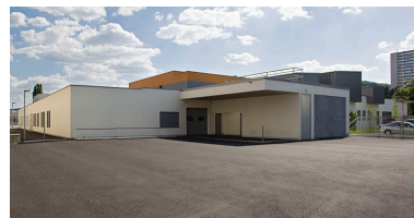
Fa ades post rieures du p le h telier, vues de trois-quart nord-est. Phot. Sonia Dourlot IVR43_20147000181NUC4AQ
