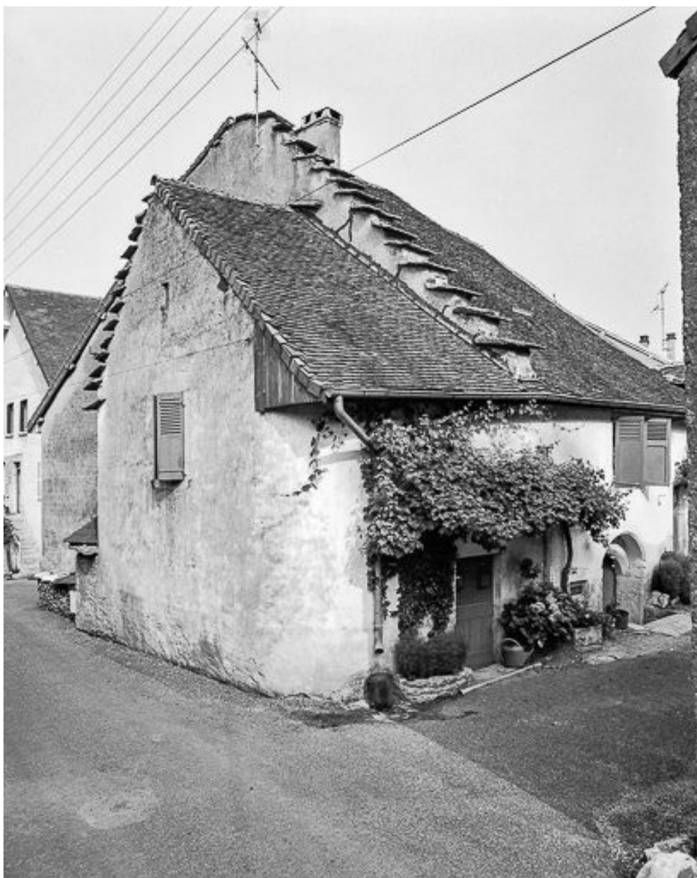
Façades antérieure et latérale gauche.
