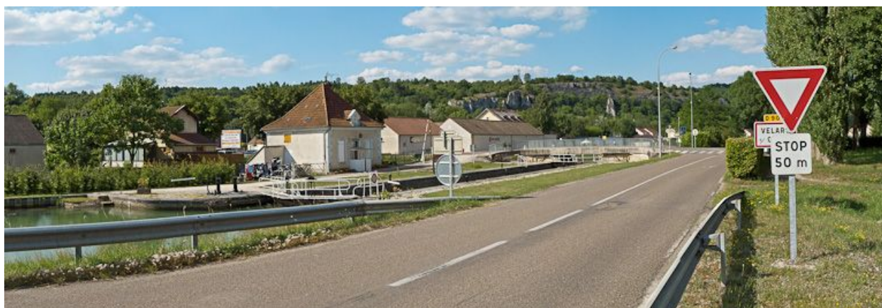
Vue d'ensemble du site d'écluse.
