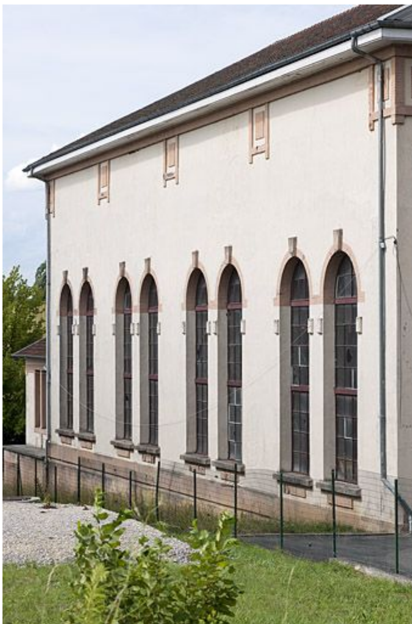
Façade ouest de la salle des machines.
