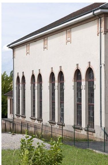
Façade ouest de la salle des machines. Phot. Jérôme Mongreville IVR43_20112501241NUC4A
