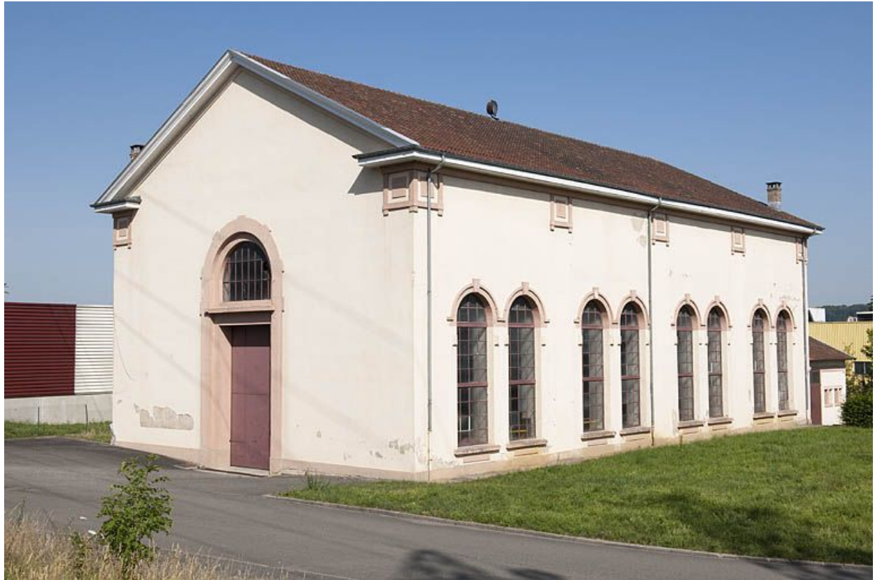
Salle des machines.
