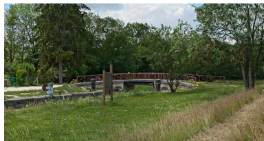
Vue du pont depuis l'amont. Phot. Pierre-Marie Barbe-Richaud IVR26_20118900287NUC4AQ
