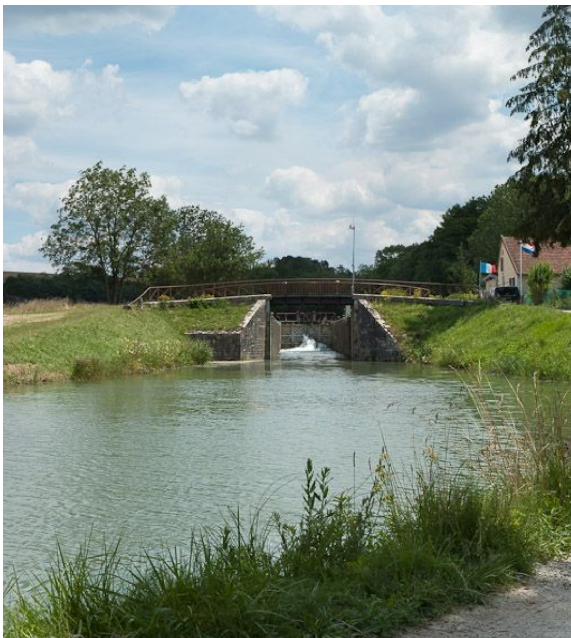
Vue du pont depuis l'aval.
