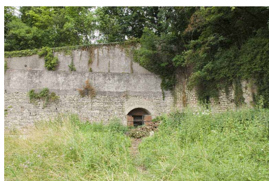
Emplacement des ateliers de fonderie. Phot. Jérôme Mongreville IVR43_20097000649NUC2A
