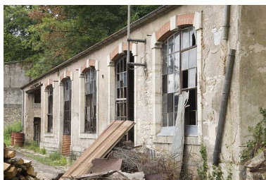
Façade d'un atelier de fabrication. Phot. Jérôme Mongreville IVR43_20097000650NUC2A
