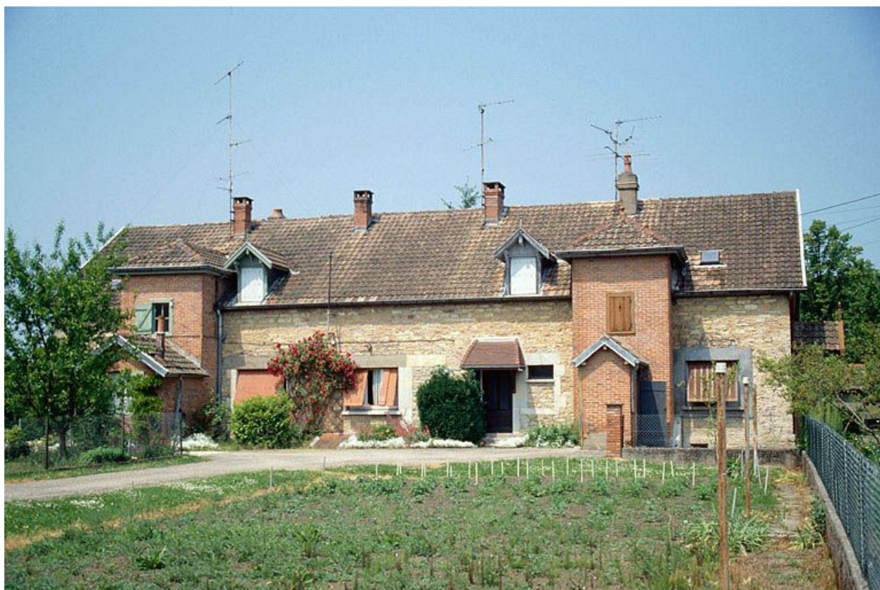
Logement de contremaître (Y) vu de face.
