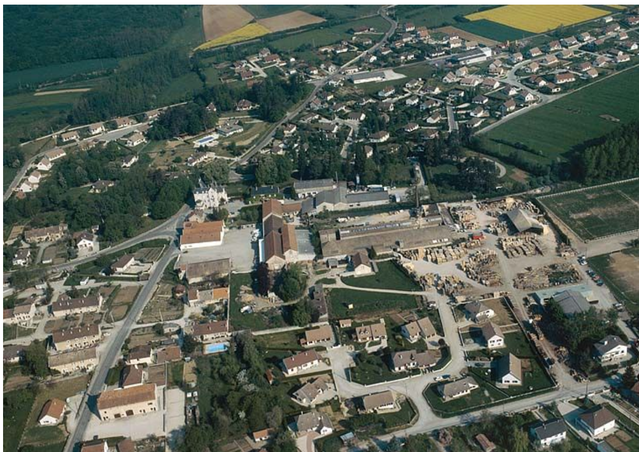
Vue aérienne de l'usine depuis le sud-est.
