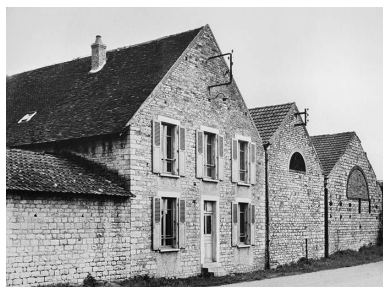
Façade antérieure du bâtiment (J).
