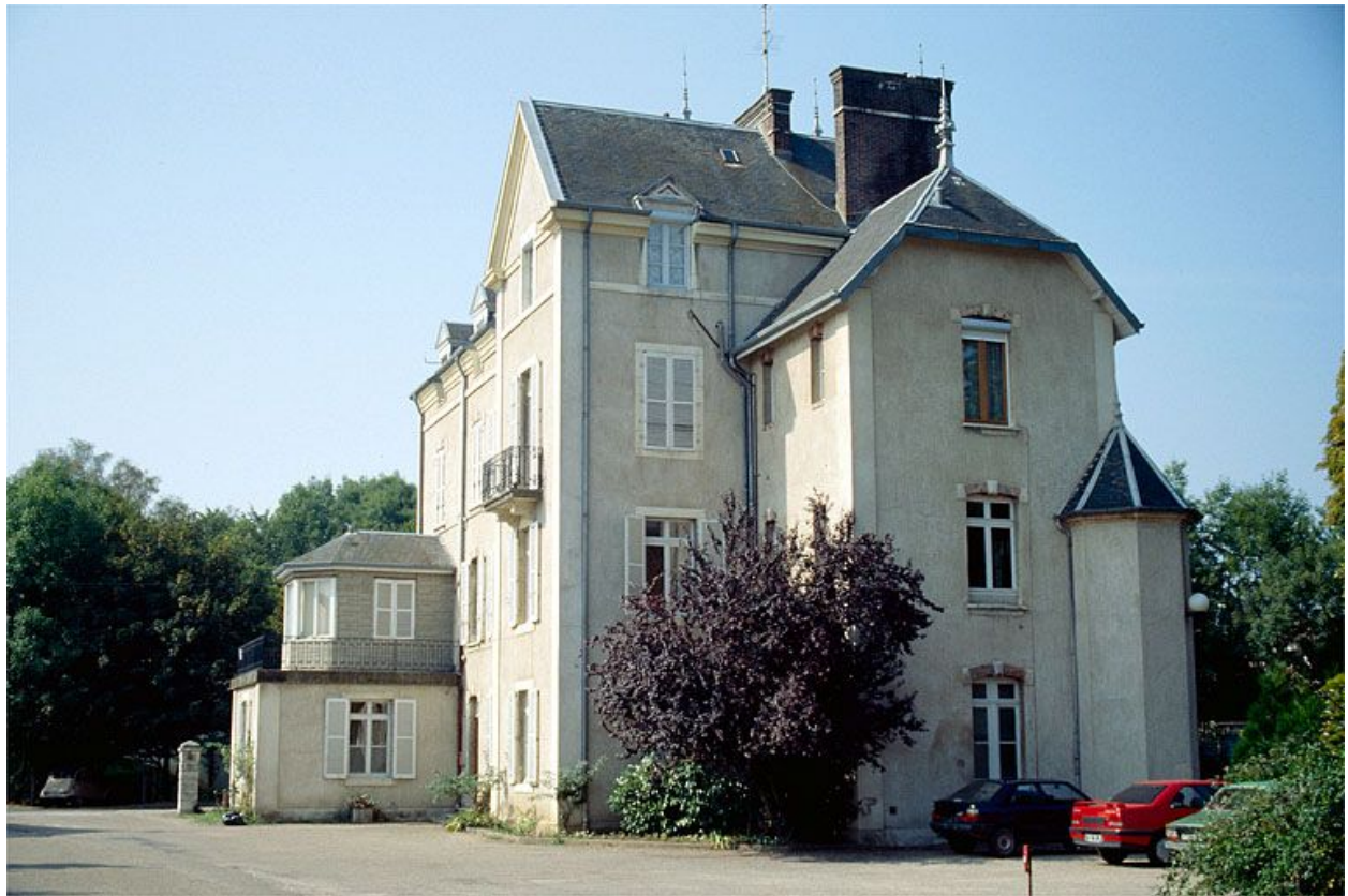
Façade latérale gauche du logement patronal (A).
