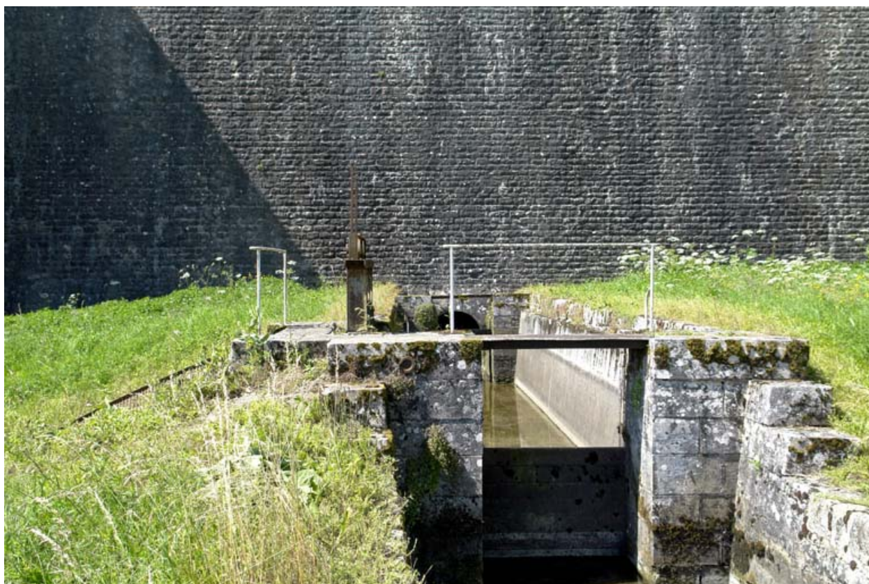
Sortie d'eau au pied du barrage et départ de la rigole d'alimentation du canal.
