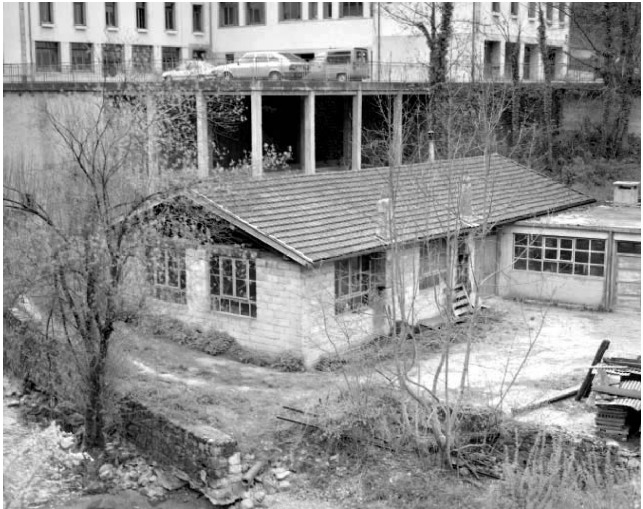
Atelier de fabrication et chaufferie de 1941.
