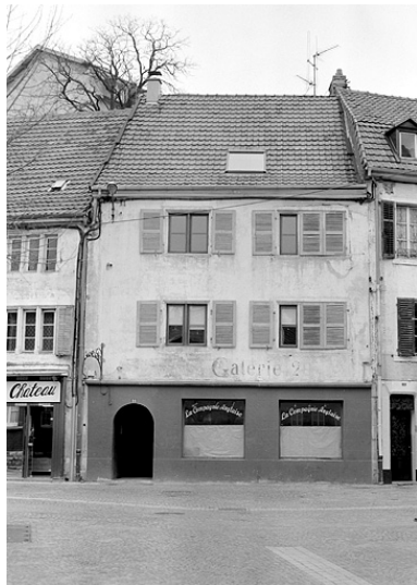
Façade sur rue. Phot. Jérôme Mongreville IVR43_19882500046X
