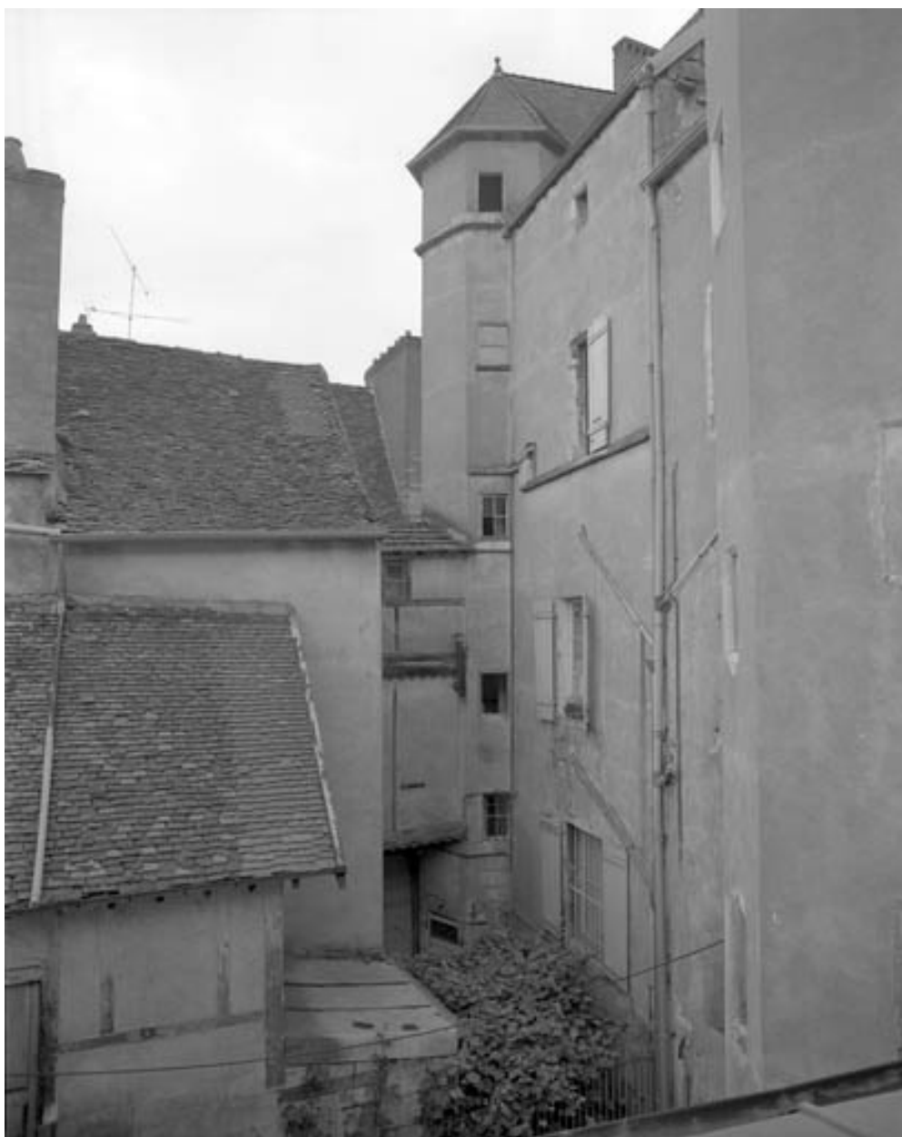
Façade postérieure depuis l'arrière-cour du 99 Grande rue.
