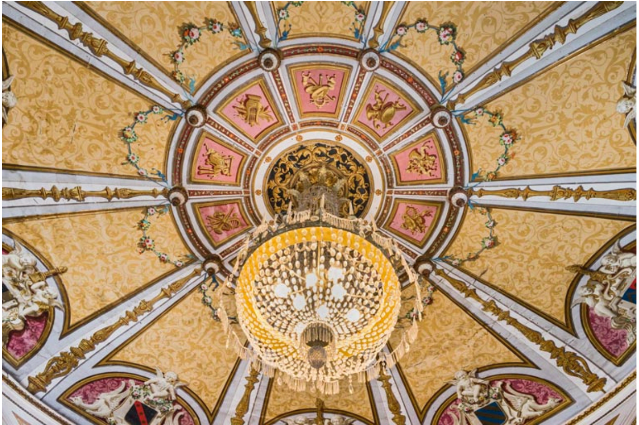
Plafond : partie centrale.
