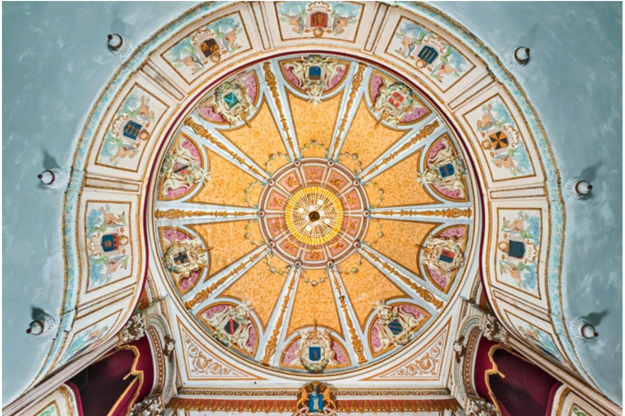
Plafond : vue d'ensemble.
