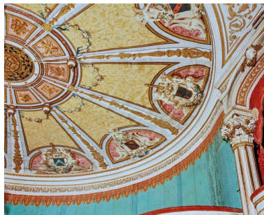
Plafond : vue partielle en 1996, avant restauration. Phot. Michel Rosso IVR26_19967100739XA
