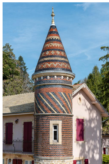
Détail de la tourelle d'angle. Phot. Pierre-Marie Barbe-Richaud IVR26_20195800067NUC4A
