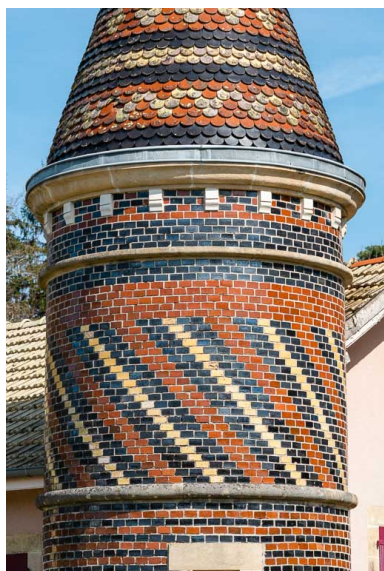
Détail de la tourelle d'angle. Phot. Pierre-Marie Barbe-Richaud IVR26_20195800068NUC4A
