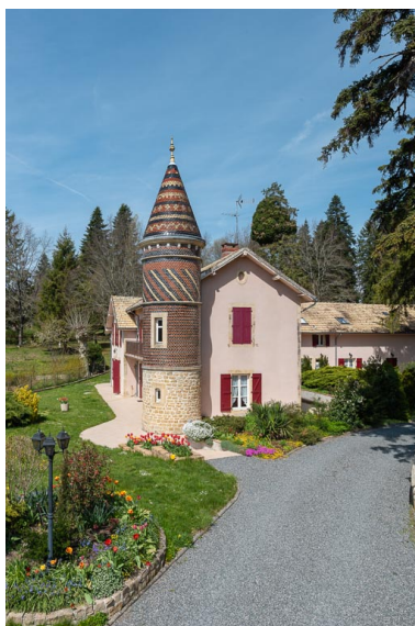
Tourelle d'angle. Phot. Pierre-Marie Barbe-Richaud IVR26_20195800075NUC4A
