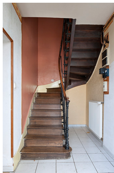
Escalier, vue d'ensemble. Phot. Jérôme Mongreville IVR43_20167000304NUC4A
