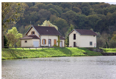
Maison du barrage et le magasin à aiguilles. Phot. Sonia Dourlot IVR43_20157000182NUC2A
