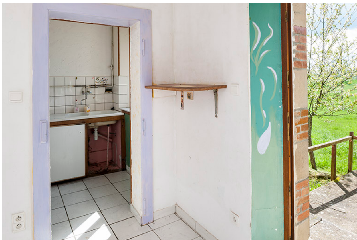
Arrière-cuisine, maison du barragiste.
