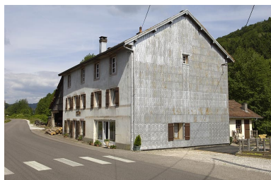
Le moulin vu de trois quarts droite. Phot. Jérôme Mongreville IVR43_20057000239NUCA
