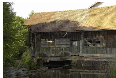
Atelier de la scierie sur le Breuchin. Phot. Jérôme Mongreville IVR43_20057000283NUCA
