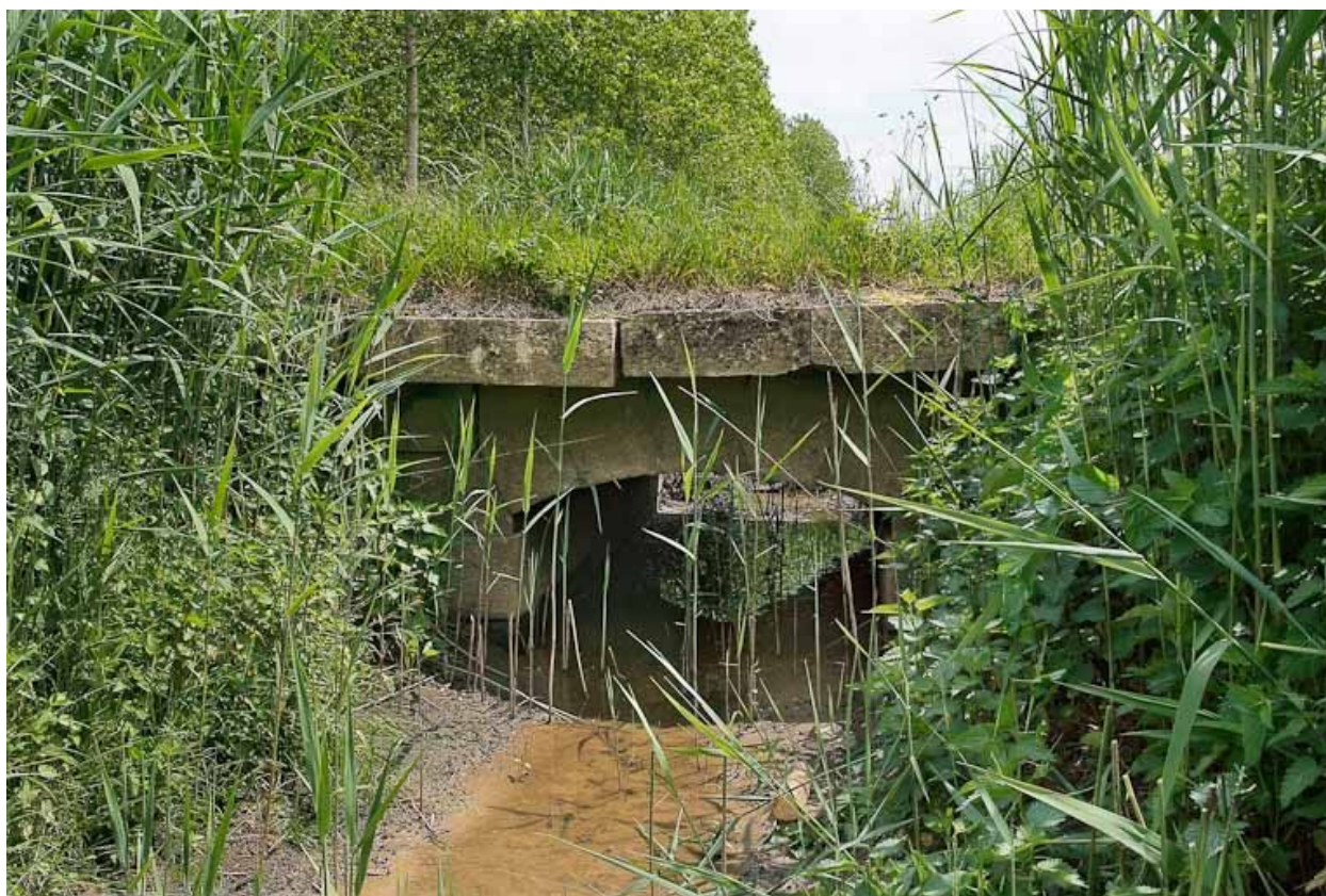
Ponceau, vue rapprochée.
