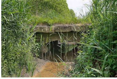
Ponceau, vue rapprochée.
