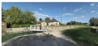
Vue d'ensemble, prise d'amont. Phot. Thierry Kuntz IVR26_20112103272NUC4A
