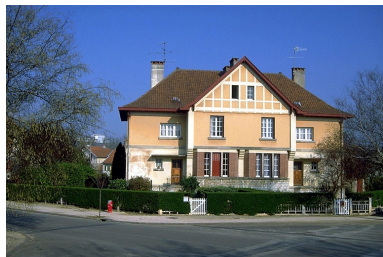
Façade antérieure. Phot. Laurent Poupard IVR43_19893900473ZA
