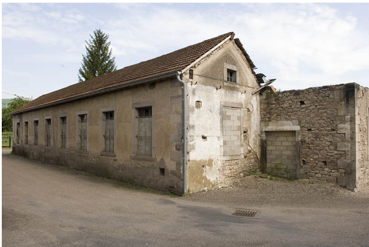
Façade nord de l'atelier de fabrication.
