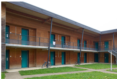
Détail de la façade intérieure de l'aile est du bâtiment d'hébergement adultes. Phot. Sonia Dourlot IVR43_20143900919NUC2A
