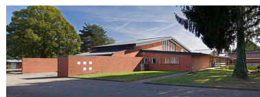
Angle nord-ouest de l'externat. Phot. Sonia Dourlot IVR43_20143900803NUC4AQ
