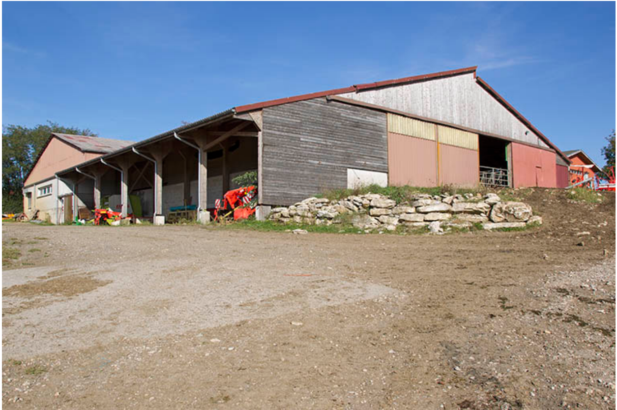
Angle sud-ouest de la ferme et des deux étables.
