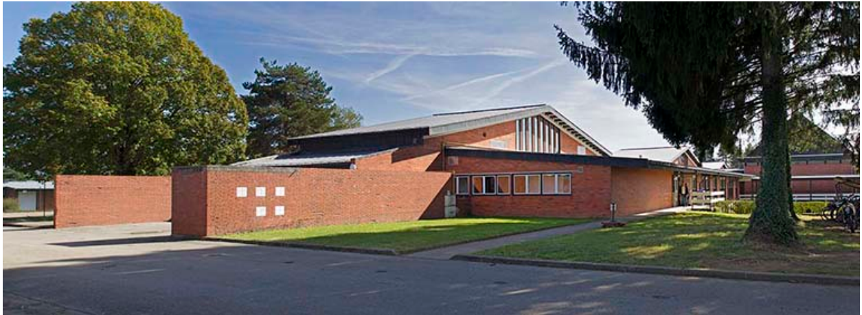
Angle nord-ouest de l'externat.
