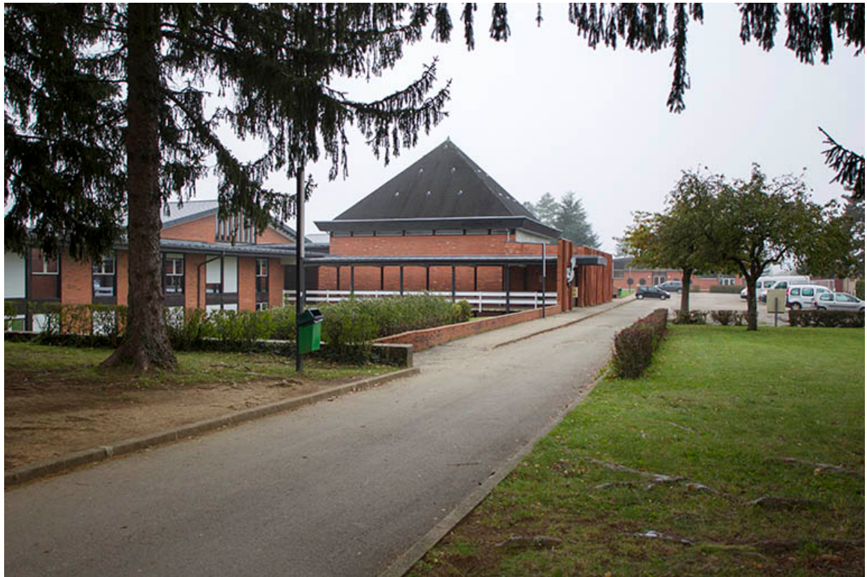
Vue sur la passerelle d'entrée, du nord-ouest de l'externat.
