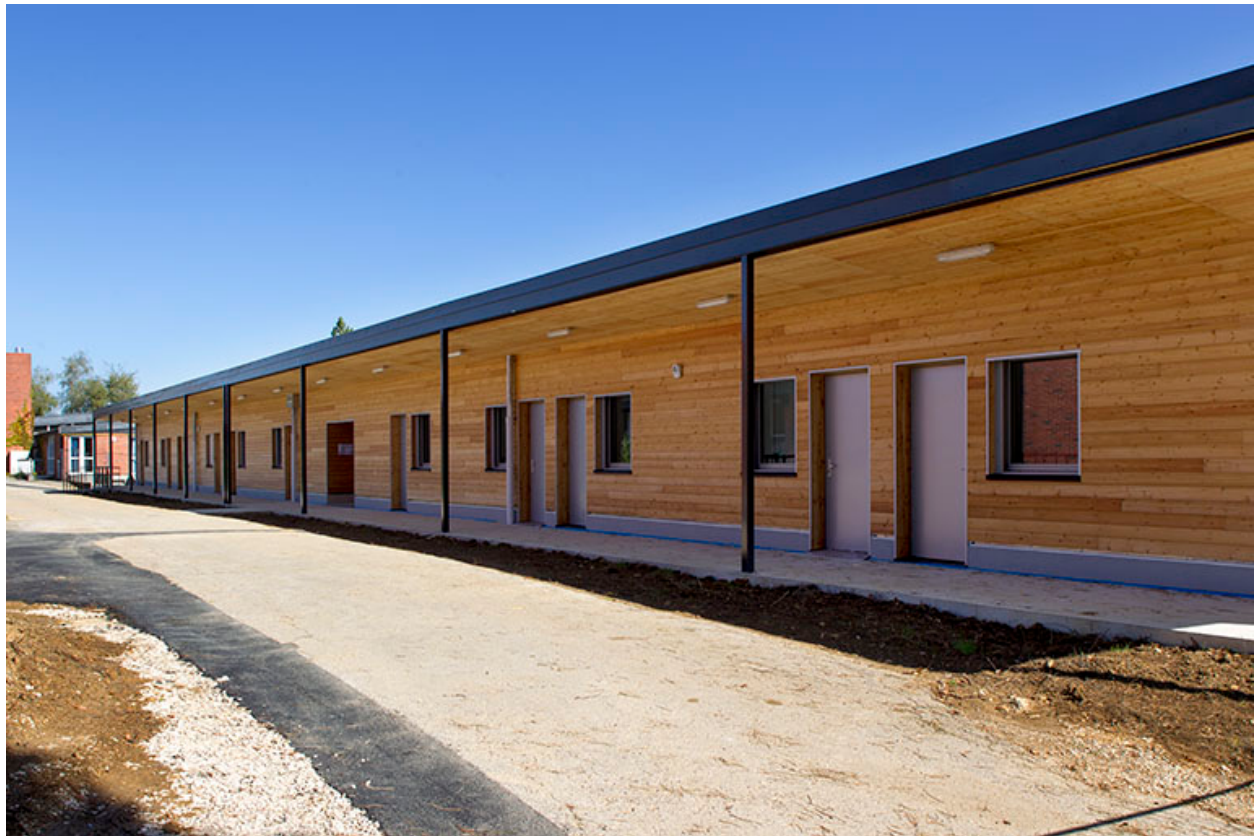
Façade antérieure - ouest - de la nouvelle construction de 2014. (salle de cours)
