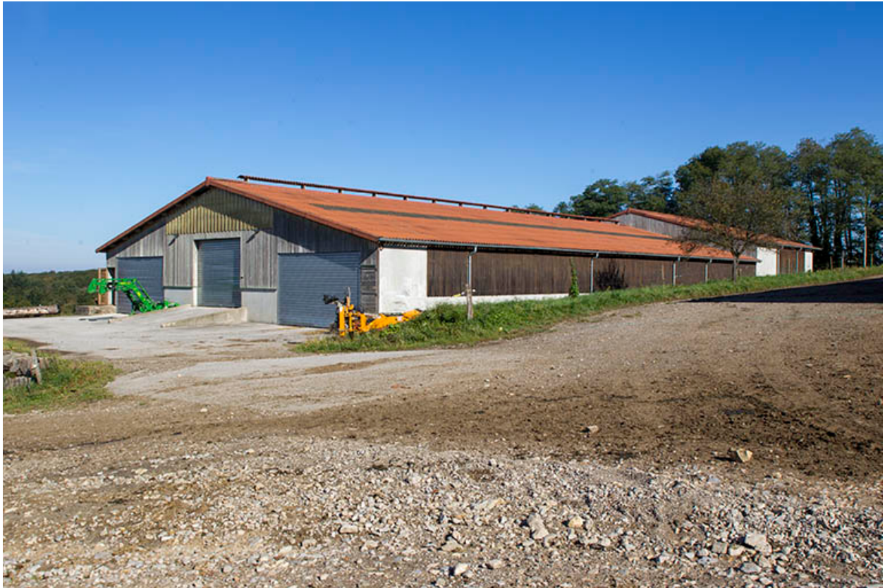
Angle sud-est, façade est de l'étable ouest.
