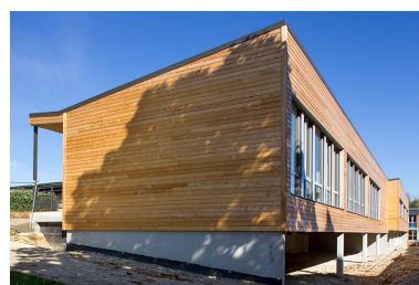
Depuis l'angle sud-est, vue sur la nouvelle construction de 2014. (salle de cours) Phot. Sonia Dourlot IVR43_20143900856NUC2A
