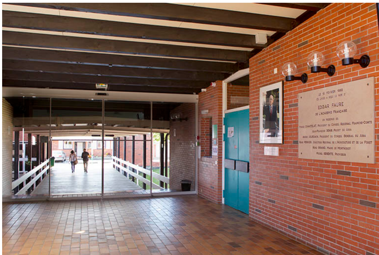
Dans le hall d'entrée face à la passerelle d'accès.
