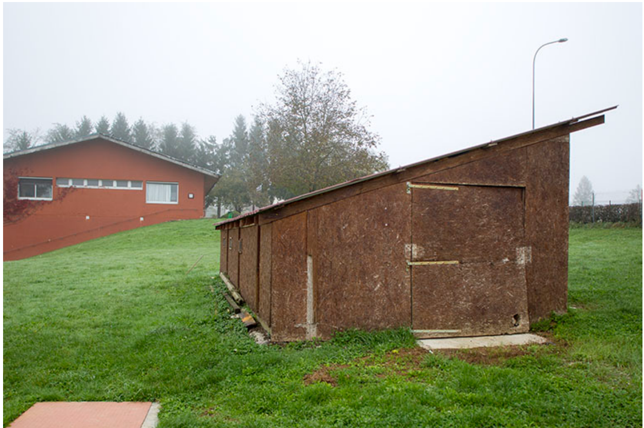
Pignons sud-ouest du poulailler nord et du magasin de commerce de l'exploitation.
