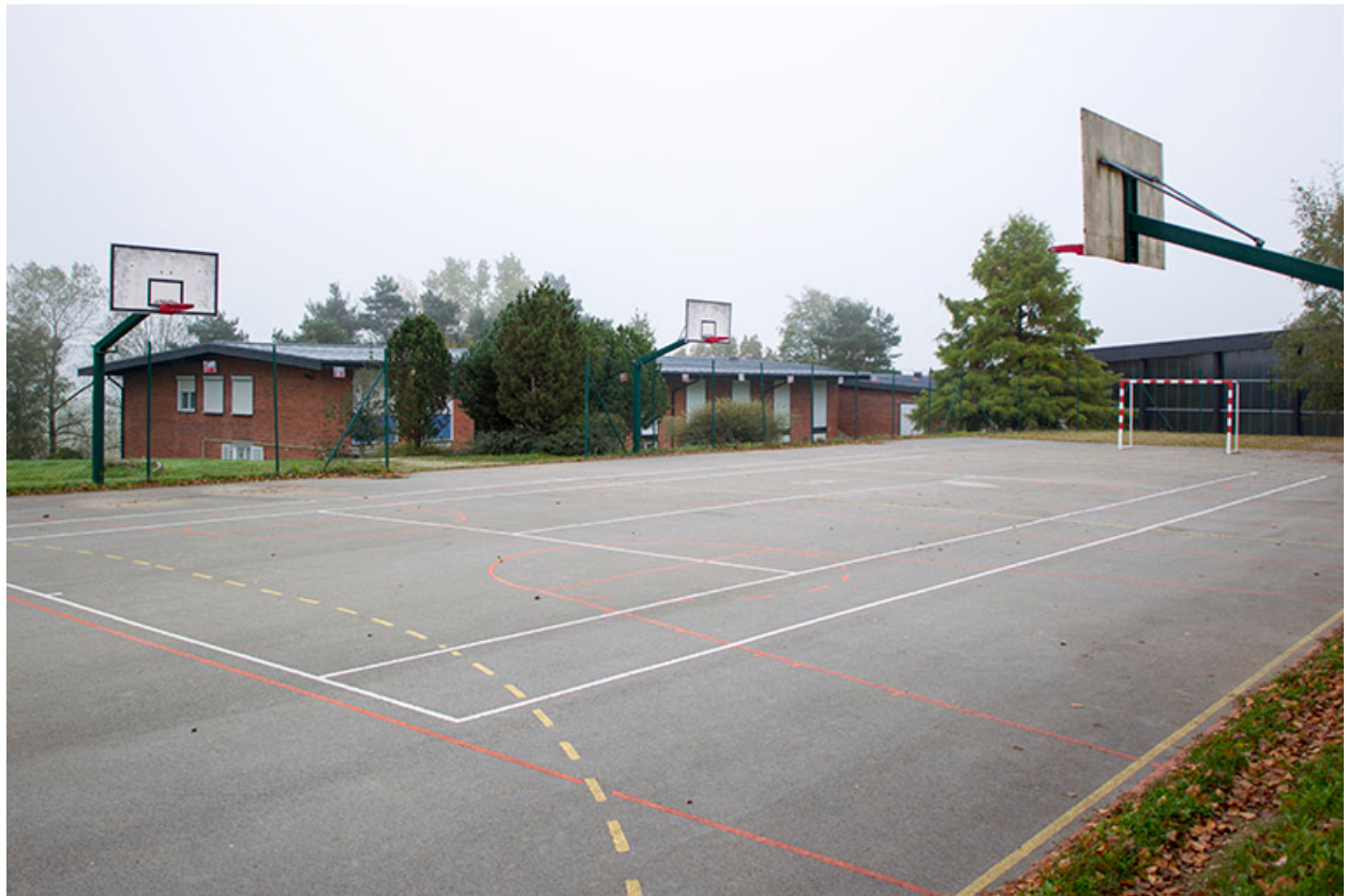
Vue sur le stade, le gymnase et l'internat depuis le nord-ouest.
