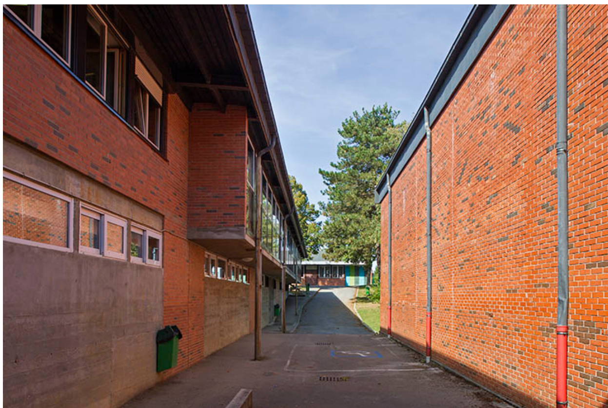
Face aux ateliers, entre le mur ouest du gymnase et la façade postérieure est de l'aile nord de l'externat.
