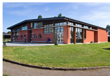
Angle nord-ouest du centre de formation des apprentis. Phot. Sonia Dourlot IVR43_20143900865NUC2A
