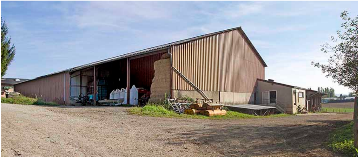
Pignon nord-ouest du fenil.
