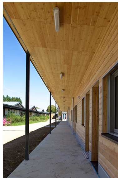
Façade antérieure - ouest - de la nouvelle construction de 2014. (salle de cours) Phot. Sonia Dourlot IVR43_20143900860NUC2A
