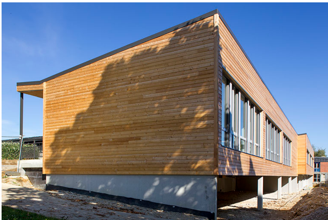
Depuis l'angle sud-est, vue sur la nouvelle construction de 2014. (salle de cours)
