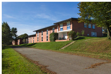
Angle nord-est, façade postérieure est de l'internat et pignon abritant des logements de fonction. Phot. Sonia Dourlot IVR43_20143900846NUC2A
