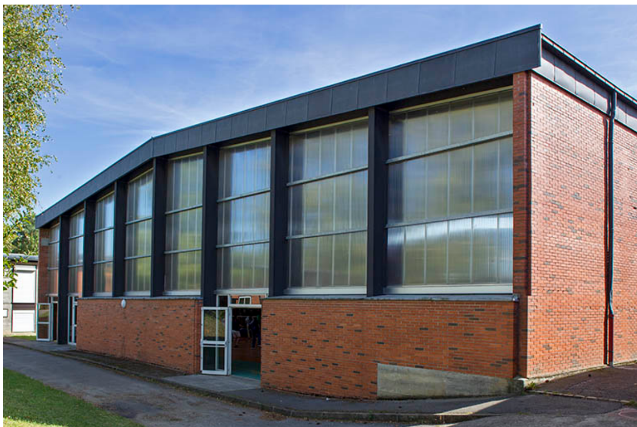
Façade nord du gymnase.
