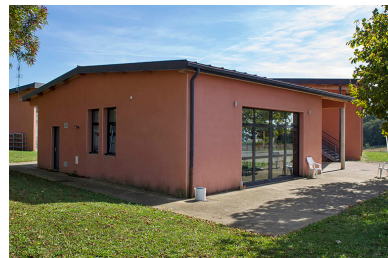
Angle nord-ouest du foyer des stagiaires. Phot. Sonia Dourlot IVR43_20143900922NUC2A
