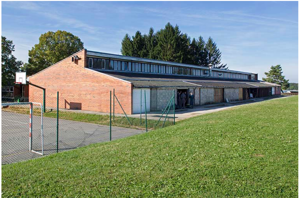
Angle nord-est, pignon est, façade postérieure nord de l'atelier.
