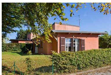
Logements : pignon sud des logements individuels au sud, le long de l'avenue. Phot. Sonia Dourlot IVR43_20143900911NUC2A
