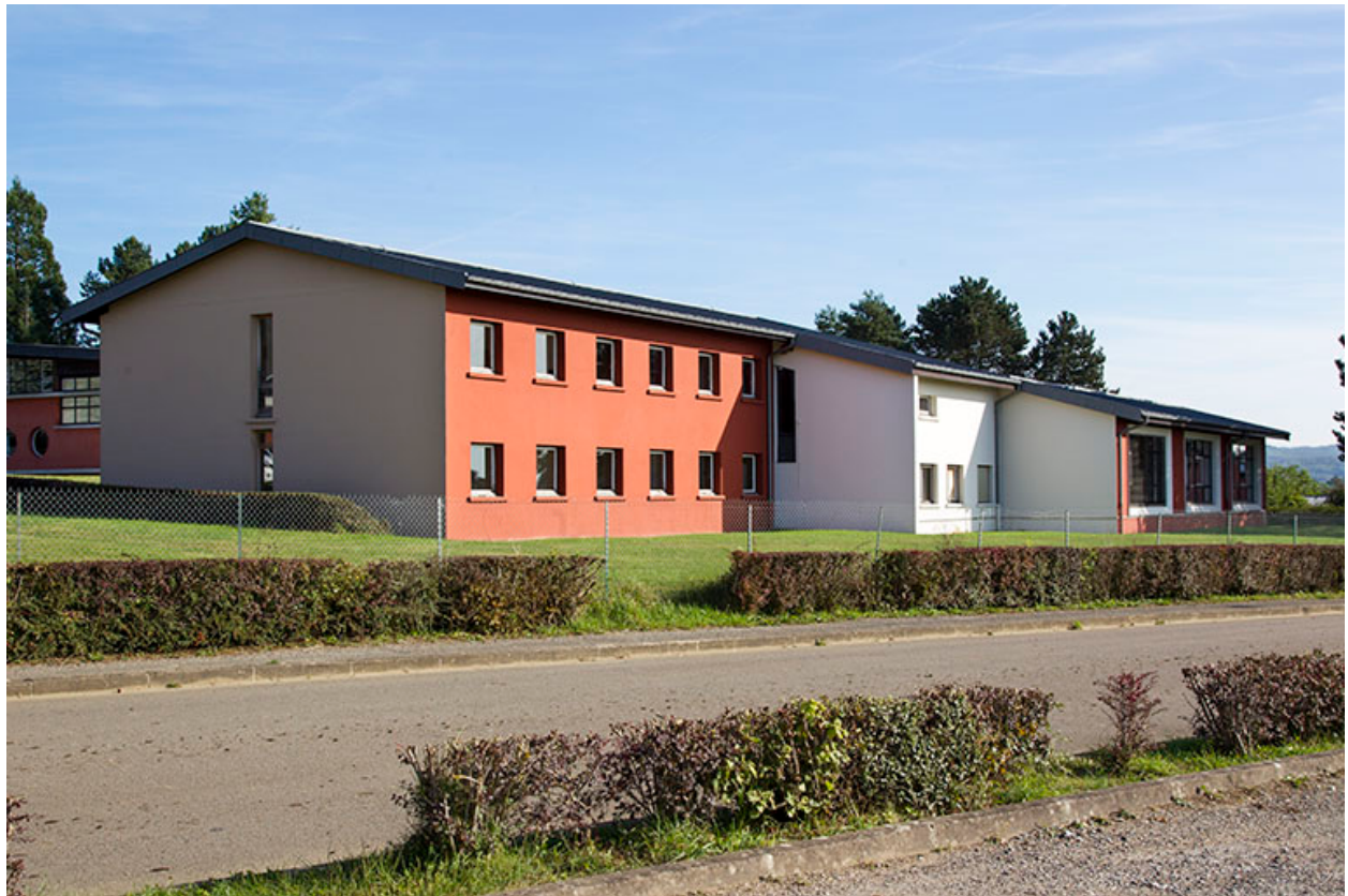
Façades ouest et pignon nord du Centre de Formation Professionnelle et de Promotion Agricoles.
