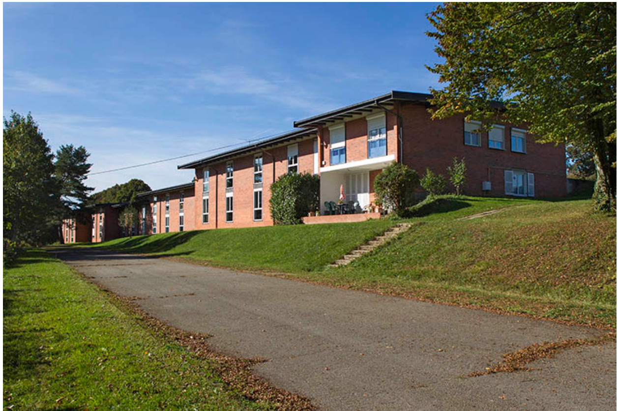
Angle nord-est, façade postérieure est de l'internat et pignon abritant des logements de fonction.
