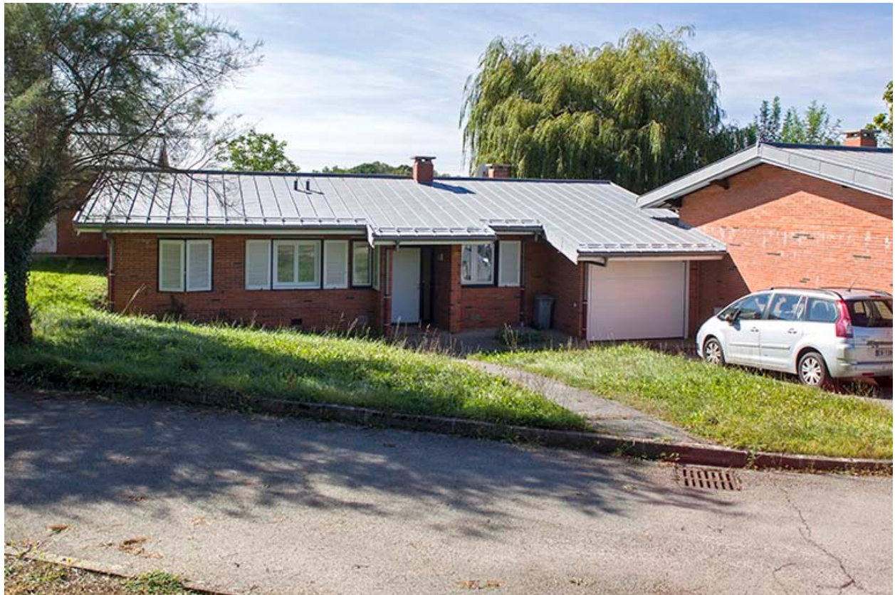
Logements : face antérieure-nord-de la barre au sud.
