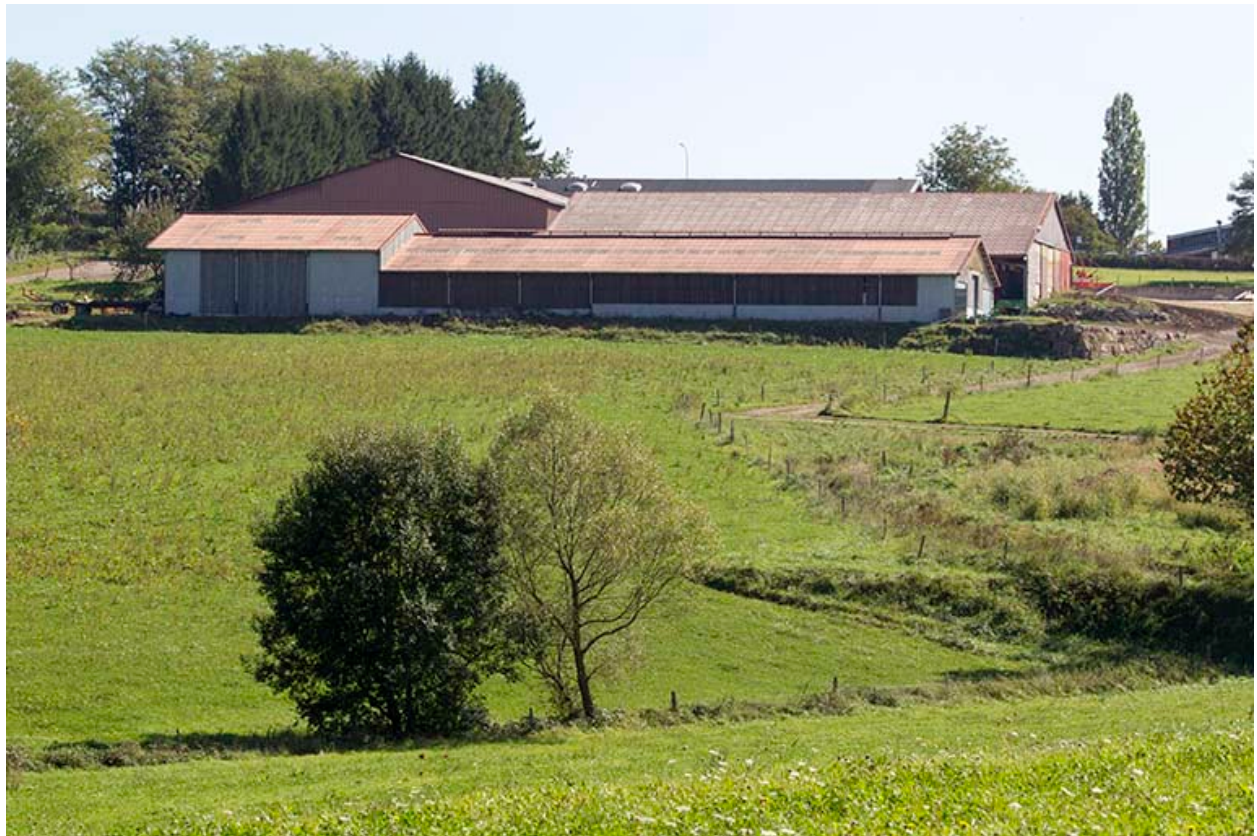
Vue d'ensemble des bâtiments agricoles depuis l'ouest.
