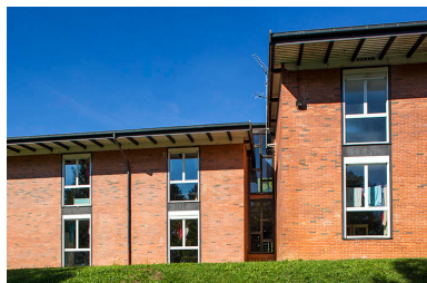
Détail de la façade postérieure est de l'internat. Phot. Sonia Dourlot IVR43_20143900848NUC2A
