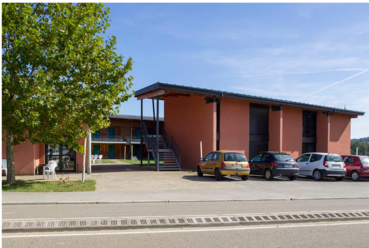
Pignon et escalier de l'aile nord-ouest du bâtiment d'hébergement adultes.
