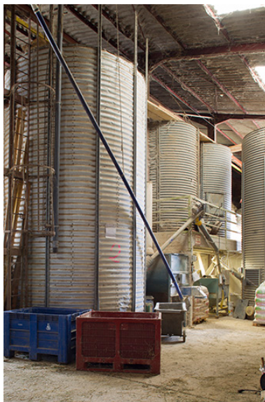
Silos dans le fenil. Phot. Sonia Dourlot IVR43_20143900893NUC2A
