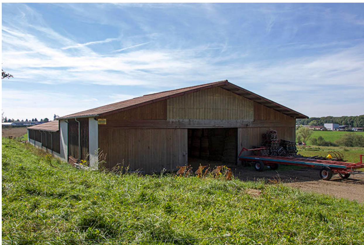
Pignon nord de l'étable ouest.
