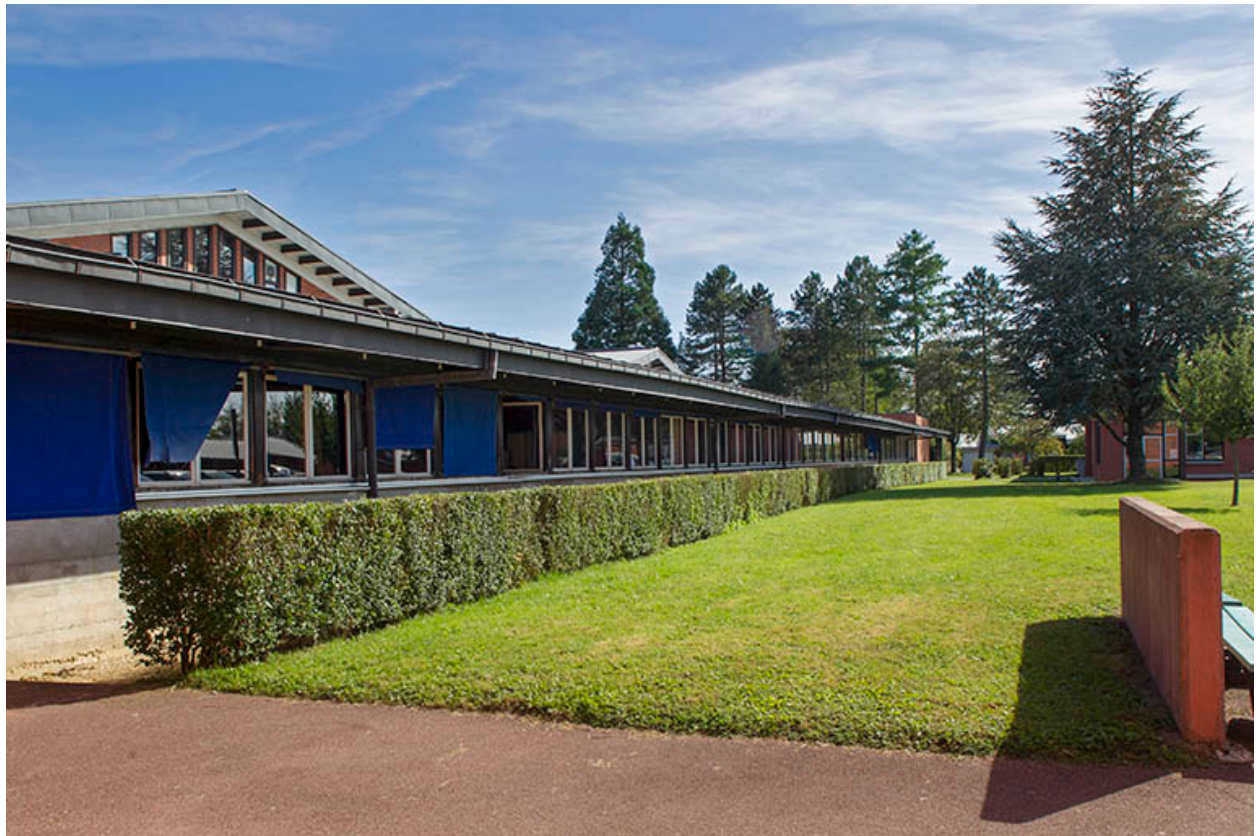
Façade antérieure ouest de l'aile sud du lycée.
