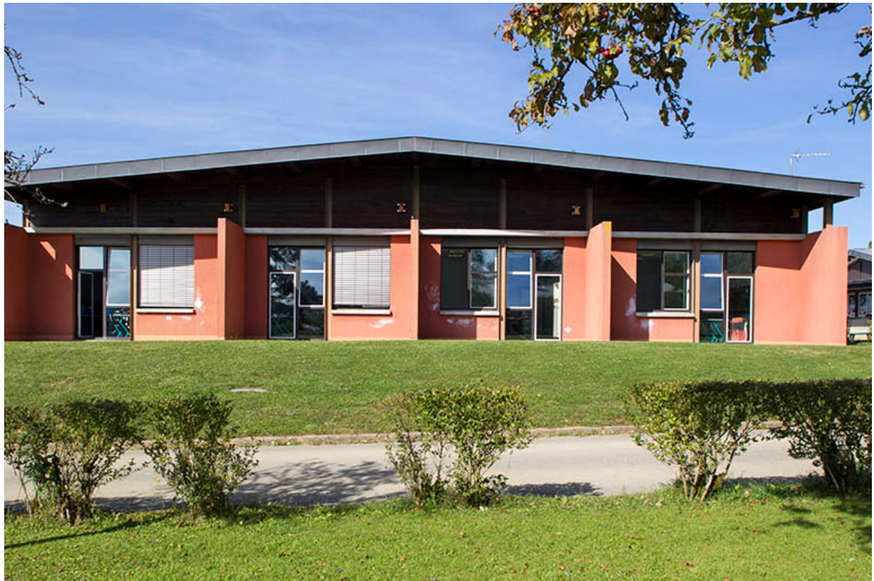
Façade sud du centre de formation des apprentis.
