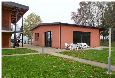
Angle sud-est et pignon sud du foyer des stagiaires. Phot. Sonia Dourlot IVR43_20143900921NUC2A
