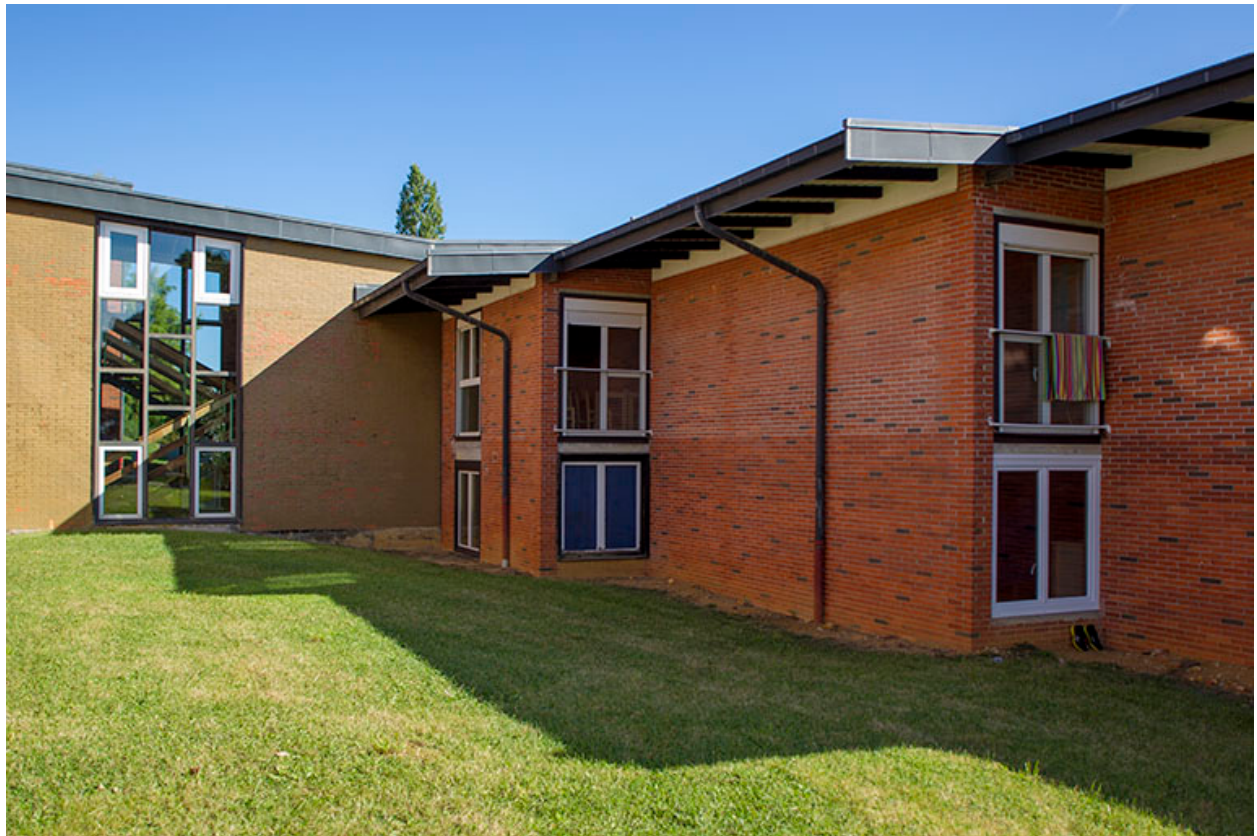
Cour sud entre l'externat à l'ouest et l'internat à l'est.
