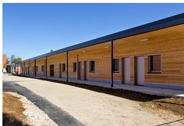
Façade antérieure - ouest - de la nouvelle construction de 2014. (salle de cours) Phot. Sonia Dourlot IVR43_20143900857NUC2A
