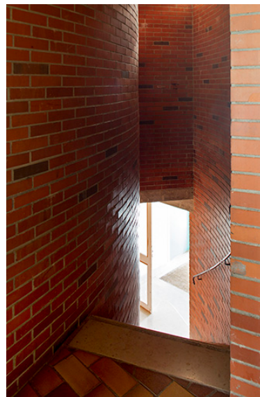
A l'intérieur du foyer, l'escalier en vis sans jour s'ouvrant à droite. Phot. Sonia Dourlot IVR43_20143900839NUC2A
