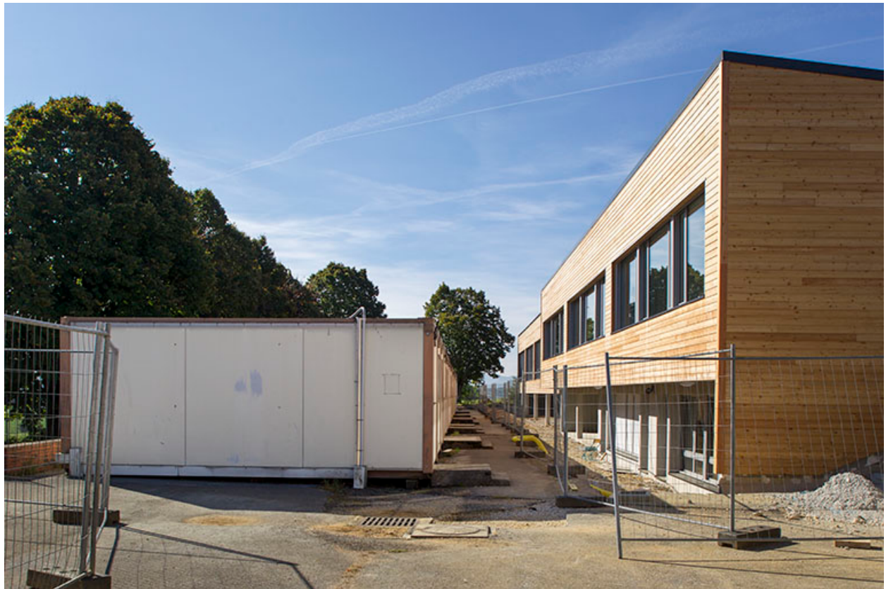
Depuis le pignon nord, vue sur les anciens préfabriqués et la nouvelle construction de 2014. (salle de cours)
