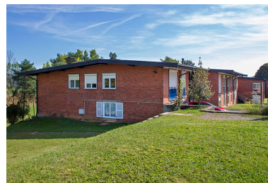
Pignon nord de l'internat. Phot. Sonia Dourlot IVR43_20143900853NUC2A
