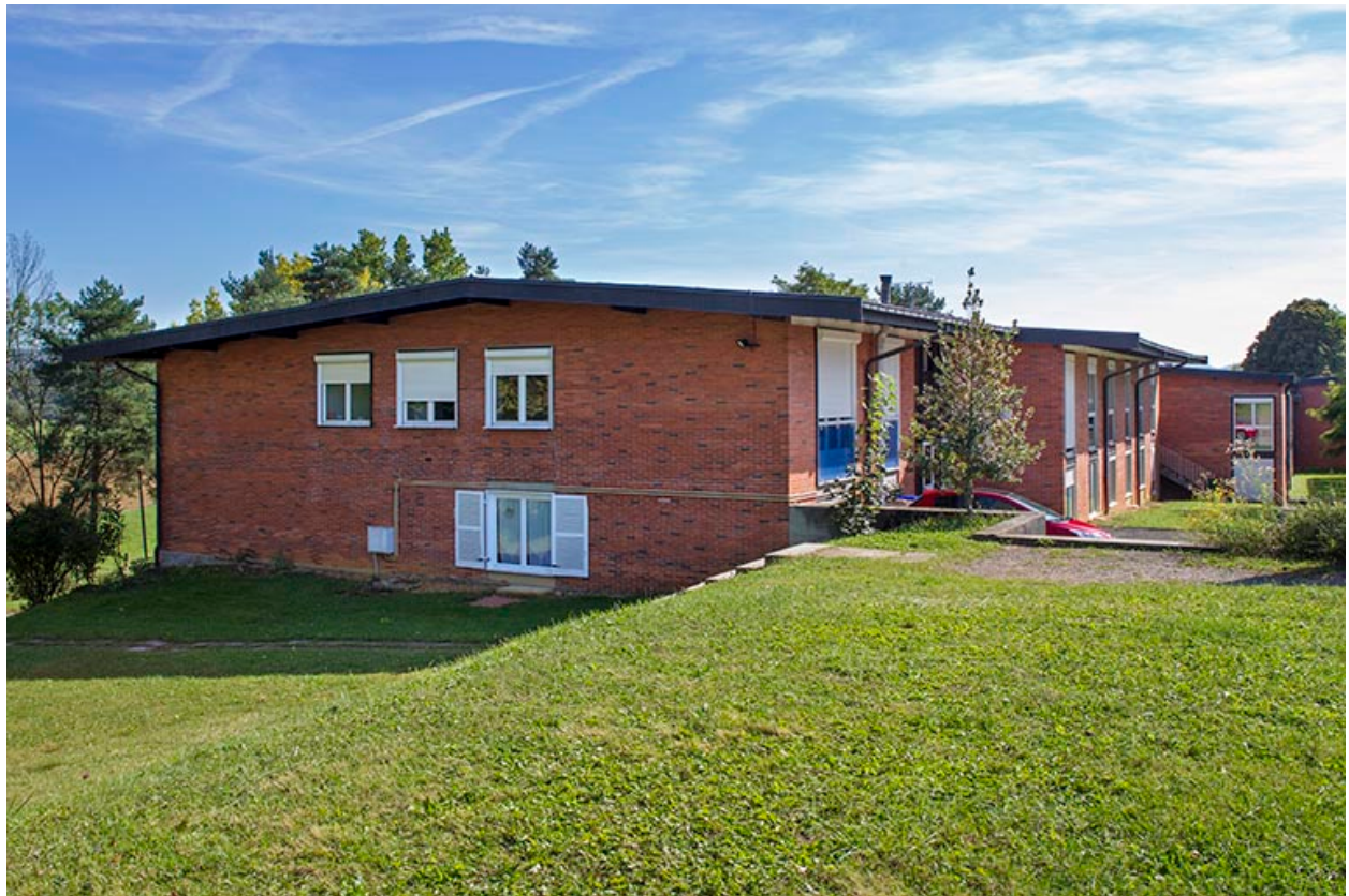
Pignon nord de l'internat.
