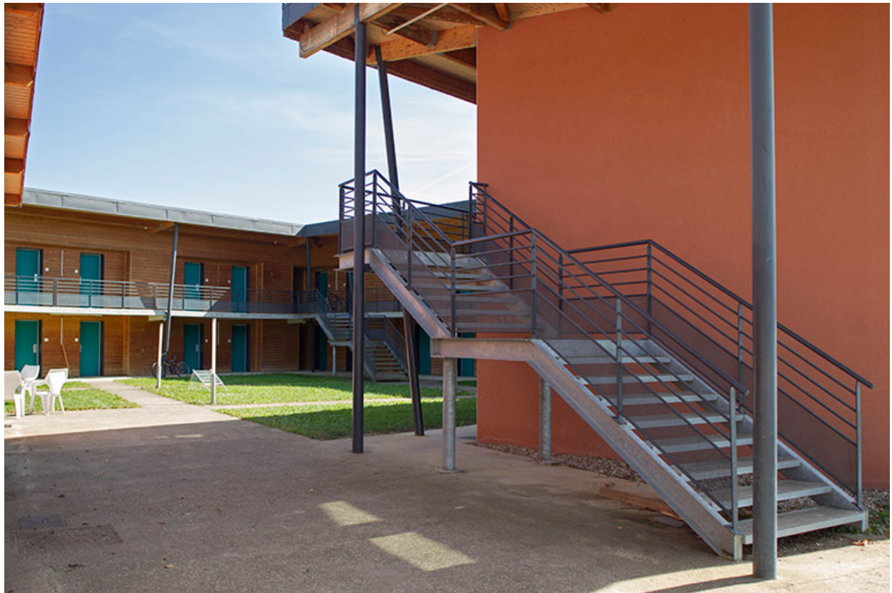
Détail de l'escalier de l'aile nord-ouest du bâtiment d'hébergement adultes.
