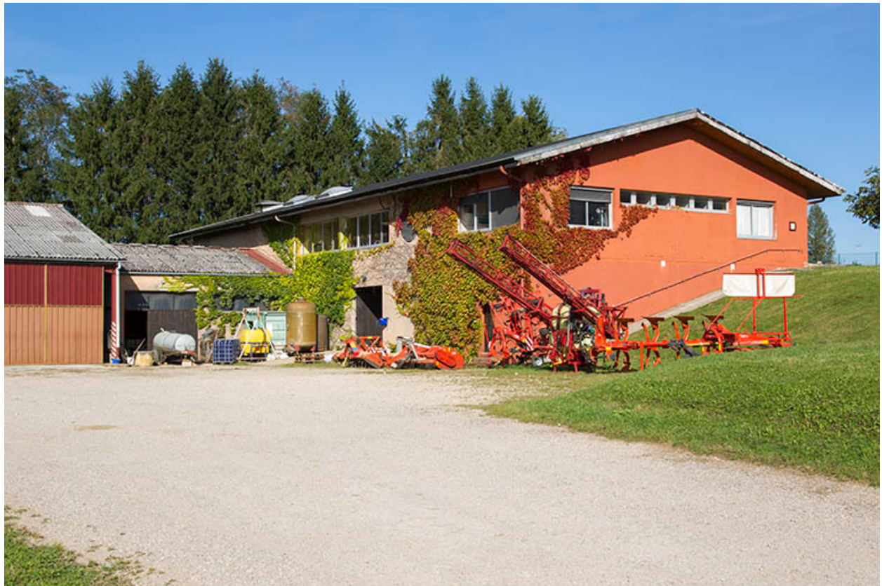
Pignon sud et façade postérieure ouest du magasin de commerce de l'exploitation.
