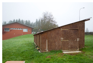
Pignons sud-ouest du poulailler nord et du magasin de commerce de l'exploitation. Phot. Sonia Dourlot IVR43_20143900875NUC2A
