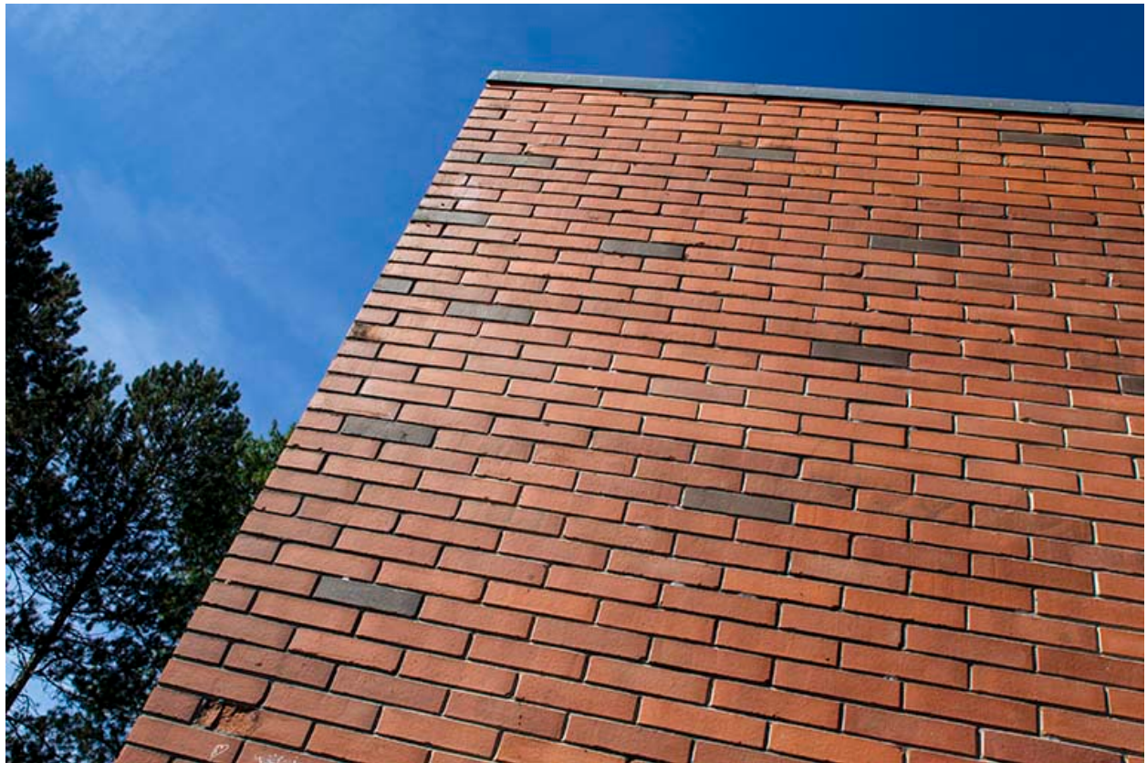
Détail de mur du gymnase.
