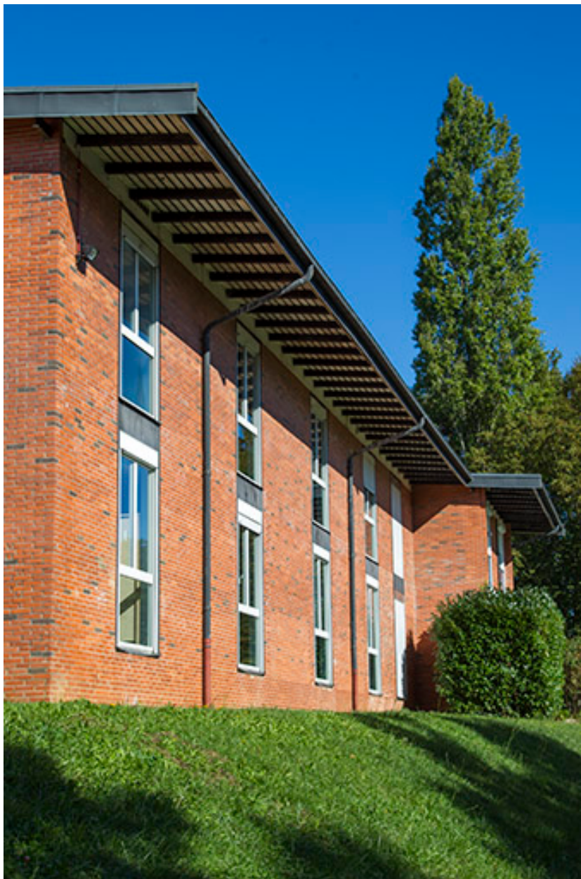
Façade postérieure est de l'internat.
