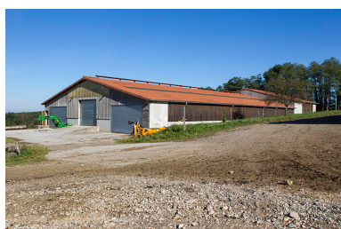
Angle sud-est, façade est de l'étable ouest. Phot. Sonia Dourlot IVR43_20143900899NUC2A
