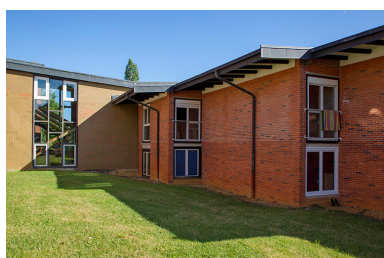
Cour sud entre l'externat à l'ouest et l'internat à l'est. Phot. Sonia Dourlot IVR43_20143900851NUC2A
