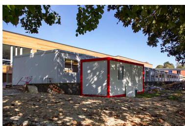
Depuis l'angle sud-est, vue sur les anciens préfabriqués et la nouvelle construction de 2014. (salle de cours) Phot. Sonia Dourlot IVR43_20143900854NUC2A
