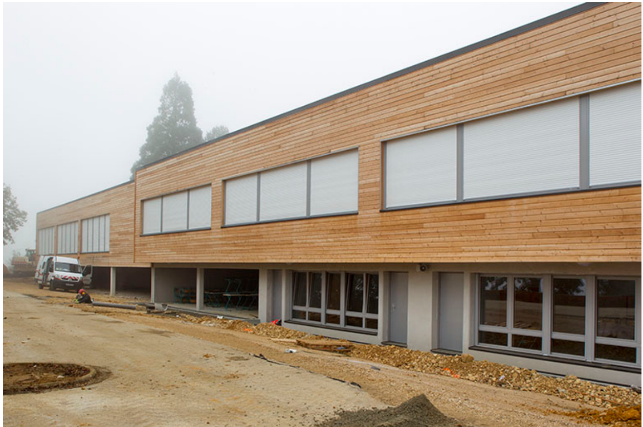
Façade postérieure - est - de la nouvelle construction de 2014. (salle de cours)
