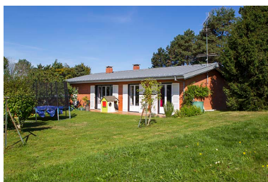
Logements : face postérieure- sud de la barre au sud, extrémité est. Phot. Sonia Dourlot IVR43_20143900905NUC2A
