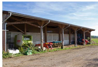
Détail de la façade ouest de la ferme et des deux étables. Phot. Sonia Dourlot IVR43_20143900891NUC2A
