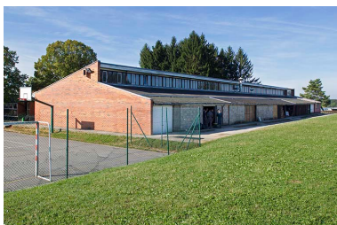
Angle nord-est, pignon est, façade postérieure nord de l'atelier. Phot. Sonia Dourlot IVR43_20143900863NUC2A
