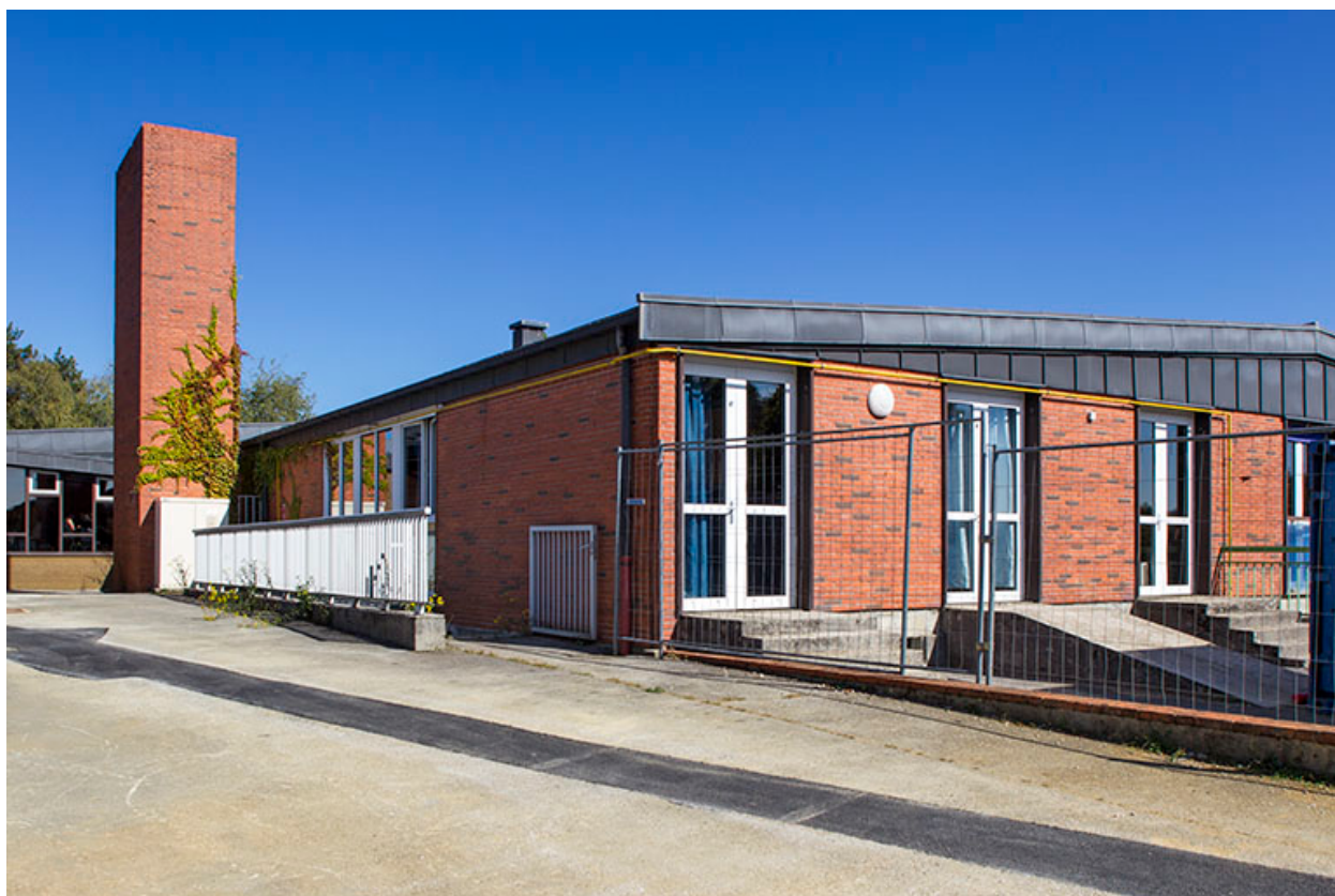
Angle sud-ouest du foyer, bâtiment postérieur de l'externat du lycée.
