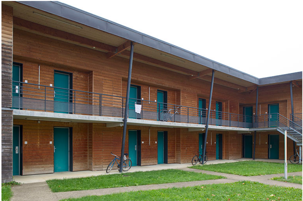
Détail de la façade intérieure de l'aile est du bâtiment d'hébergement adultes.
