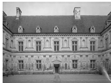
Façade sur cour (ouest). Phot. Jean-Luc Duthu IVR26_19748901366V
