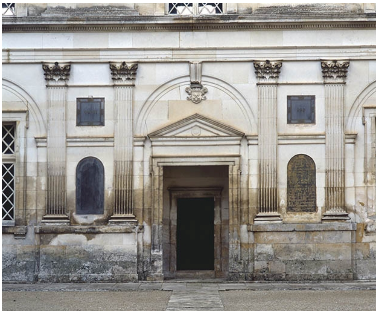
Façade sur cour, détail
