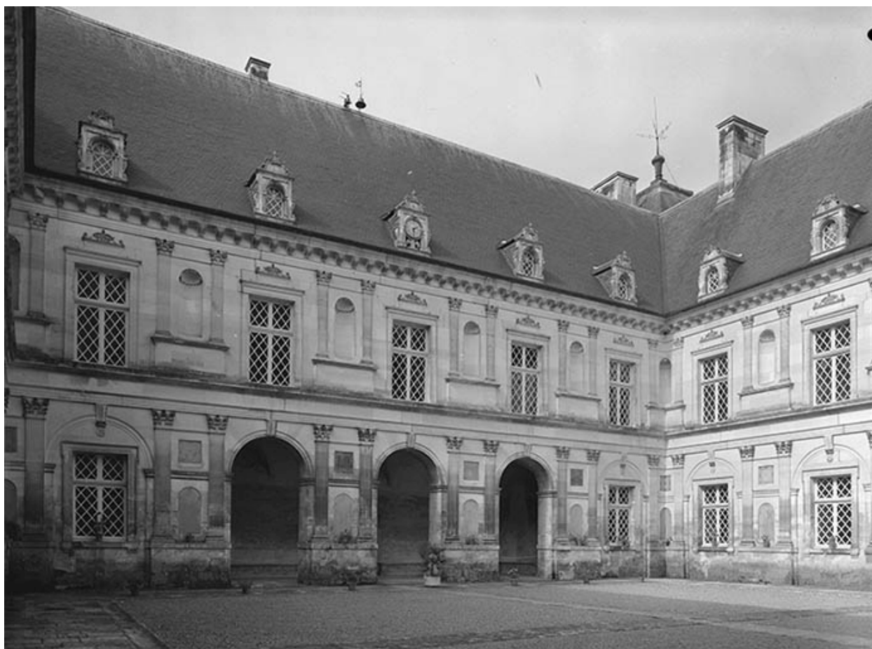
Façades sur cour (sud et ouest).
