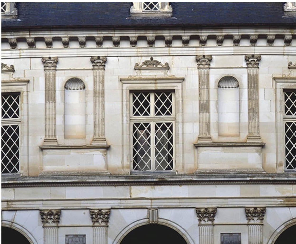
Façade sur cour, détail
