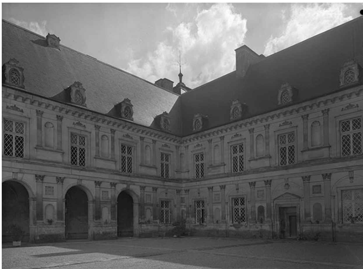
Façades sur cour (nord et est).
