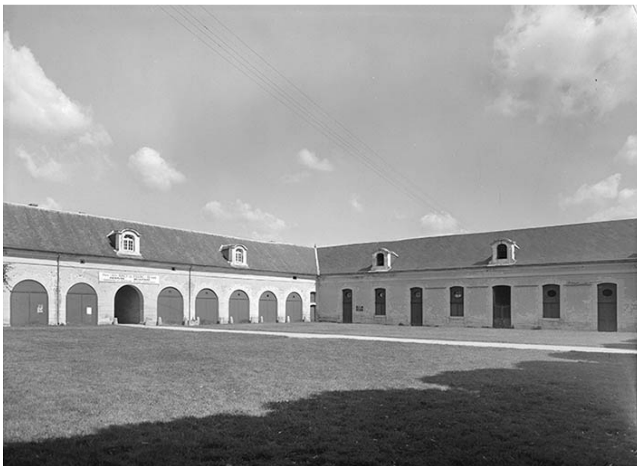
Les communs : cour des écuries.
