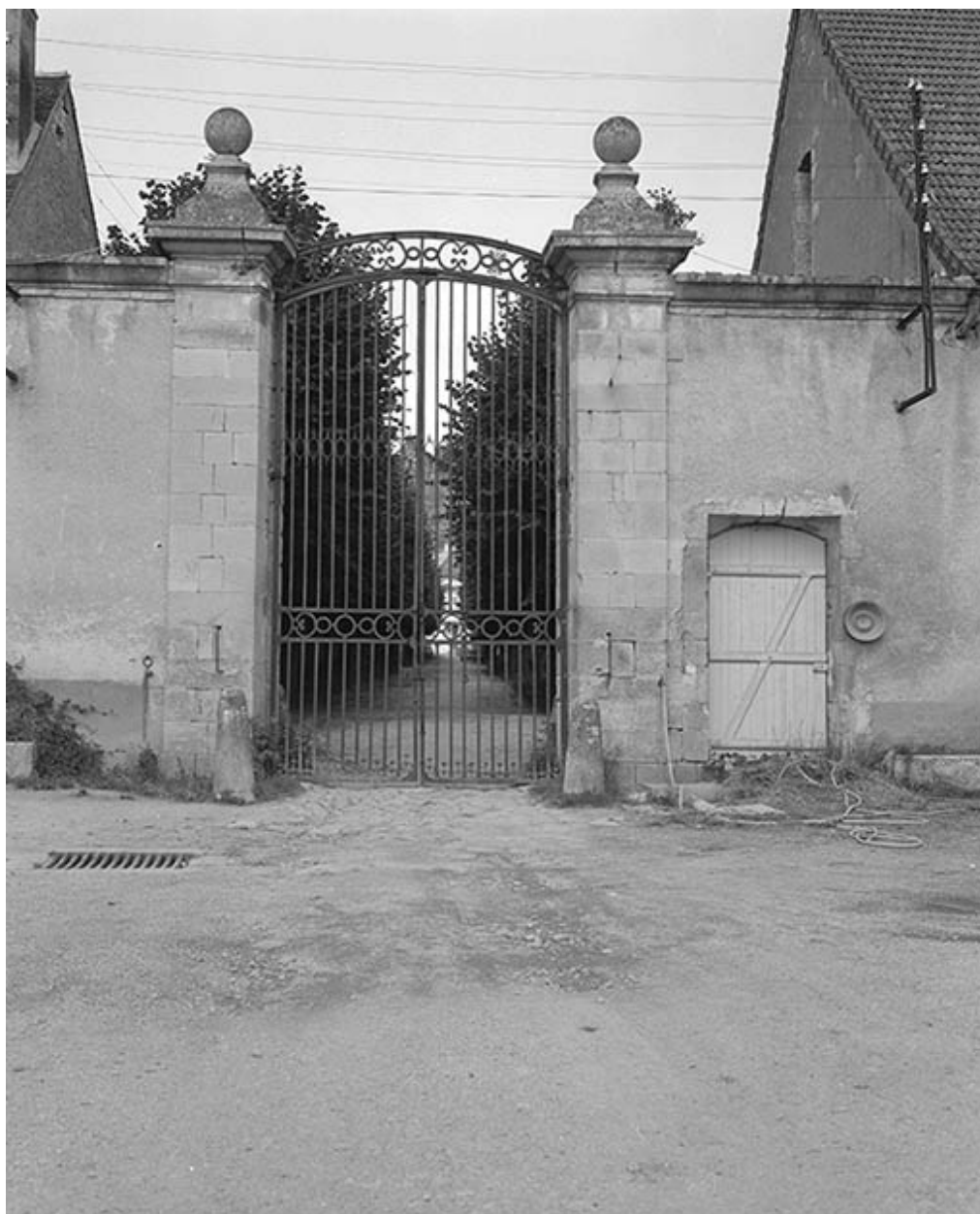
Grille d'entrée de la cour des communs.
