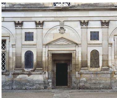
Façade sur cour, détail Phot. Jean-Luc Duthu IVR26_19918900030XA
