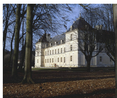
Elévation sud, vue de trois-quarts. Phot. Jean-Luc Duthu IVR26_19918900012XA
