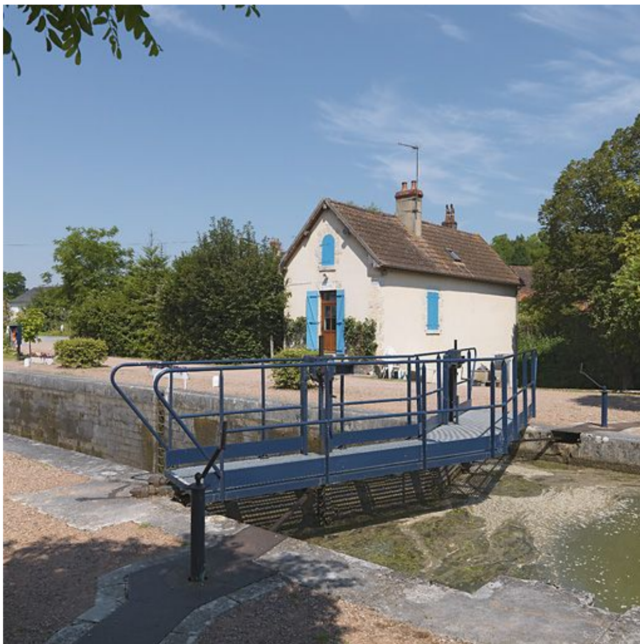
La maison éclusière, de 3/4.
