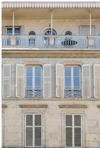
Détail de deux travées des étages. Phot. Jérôme Mongreville IVR43_20217000655NUC4A
