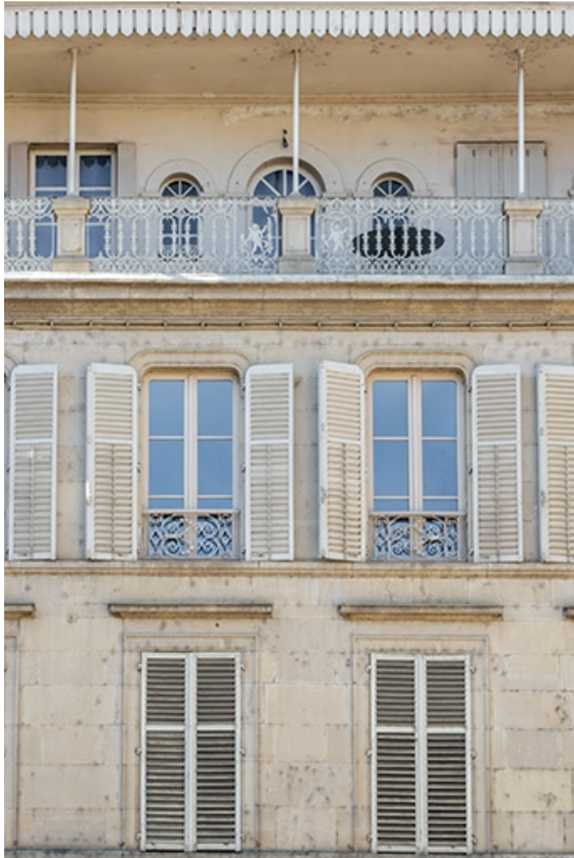
Détail de deux travées des étages.
