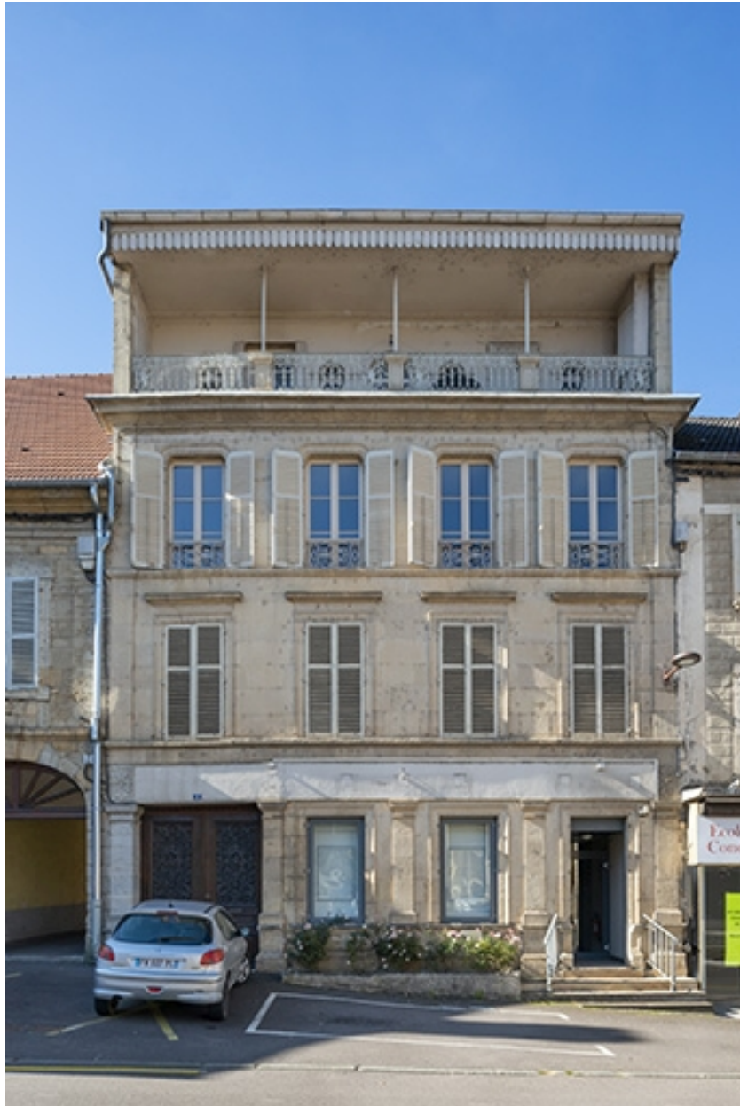
Façade de l'immeuble sur la rue.
