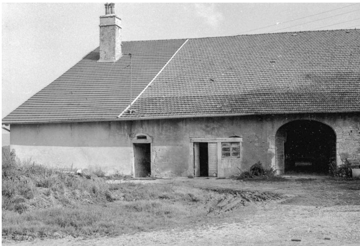
Gouttereau sur rue.
