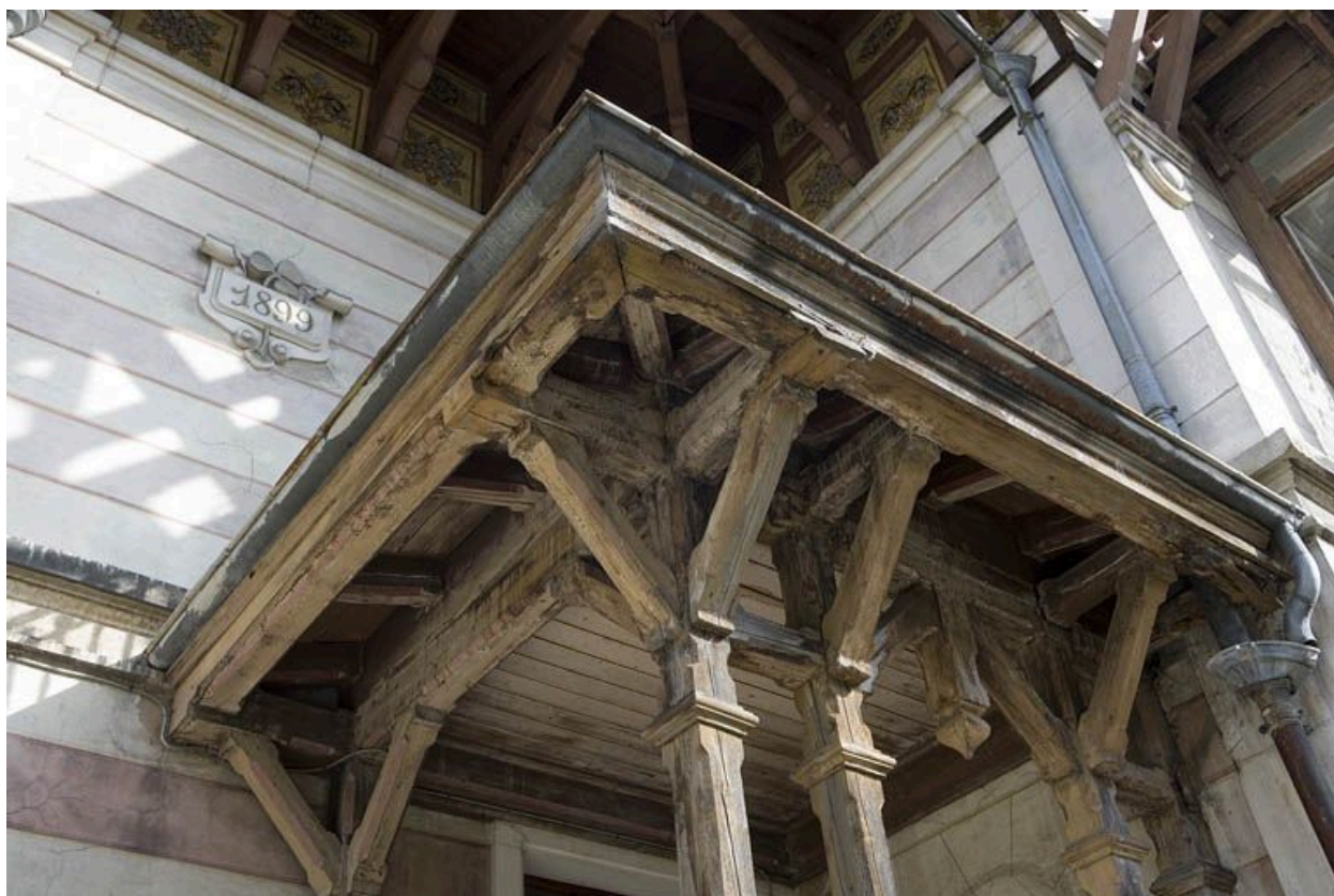
Elévation antérieure : charpente du porche.
