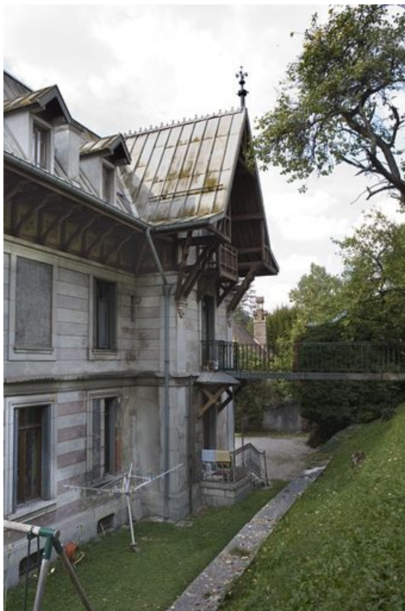
Elévation postérieure, de trois quarts gauche.
