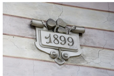
Elévation antérieure : date portée. Phot. Yves Sancey IVR43_20093900160NUC2A
