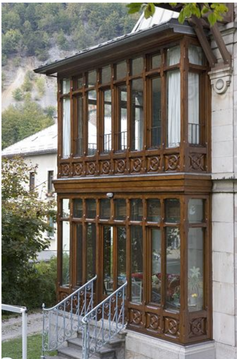
Elévation latérale droite : l'oriel.
