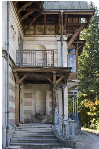
Elévation antérieure : le porche. Phot. Yves Sancey IVR43_20093900166NUC2A
