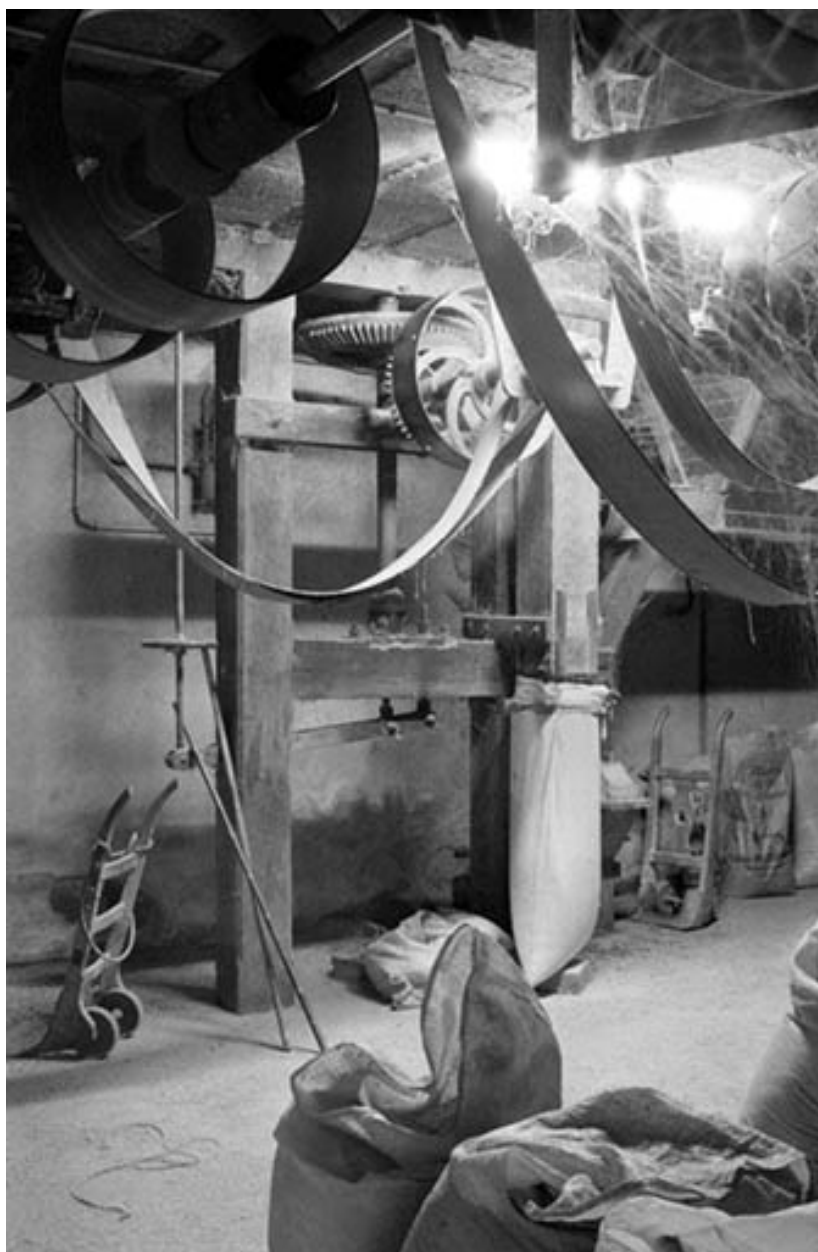
Minoterie (G), étage de soubassement : systèmes d'entraînement et d'allège d'une paire de meules.
