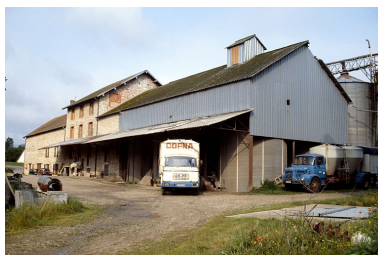
Hangar (E) et minoterie, depuis l'est. Phot. Laurent Poupard IVR43_19883900518ZA
