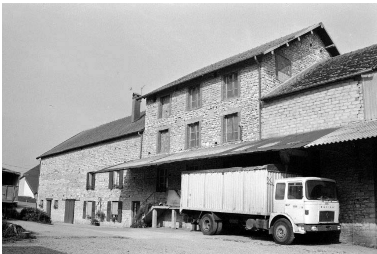
Minoterie (G, H) et logement patronal (I).
