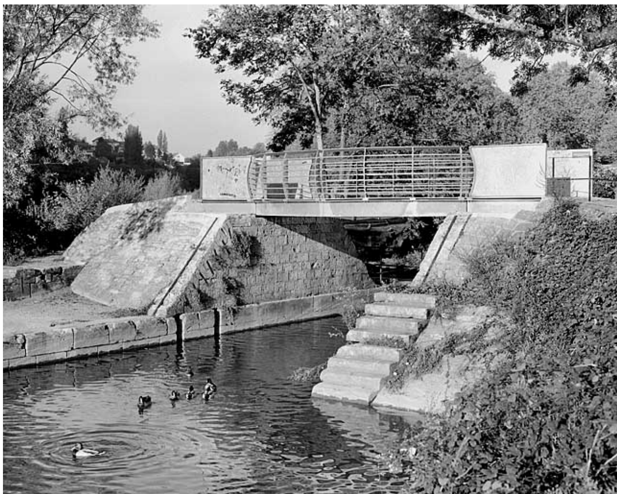
Passerelle de halage, depuis l'aval.
