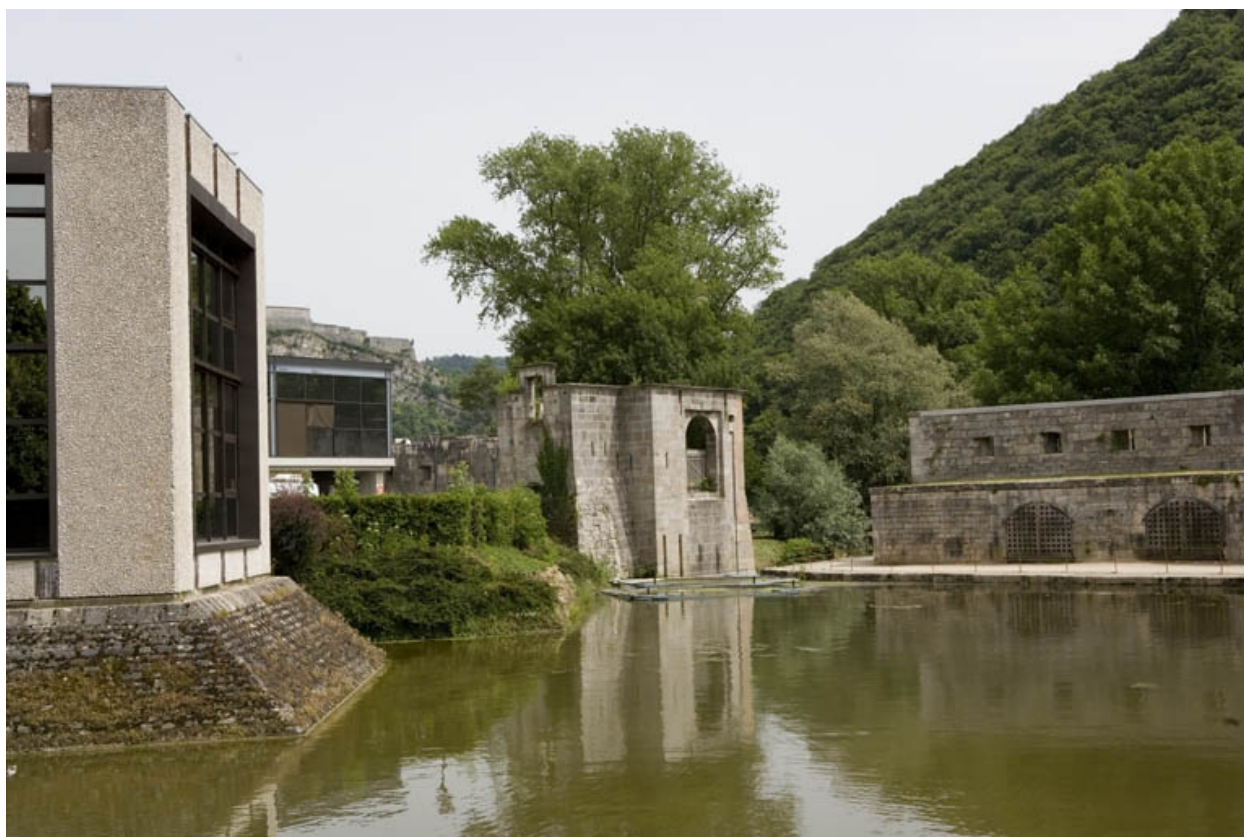
Bassin et chenal, interrompant la courtine.
