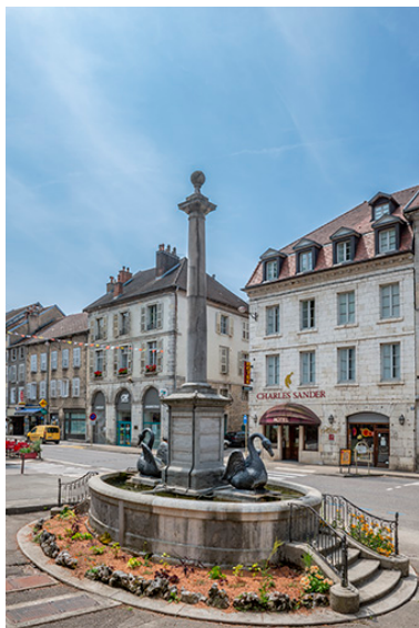
Vue d'ensemble depuis la rue d'Orgemont. Phot. Jérôme Mongreville IVR43_20233900656NUC4A
