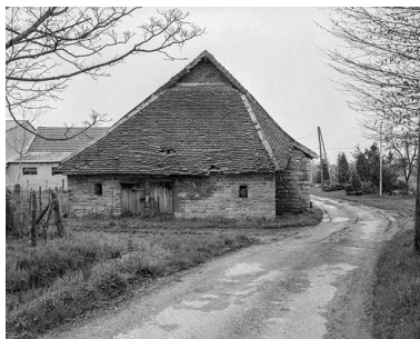
Pignon gauche. Phot. Jérôme Mongreville IVR43_19853900047X
