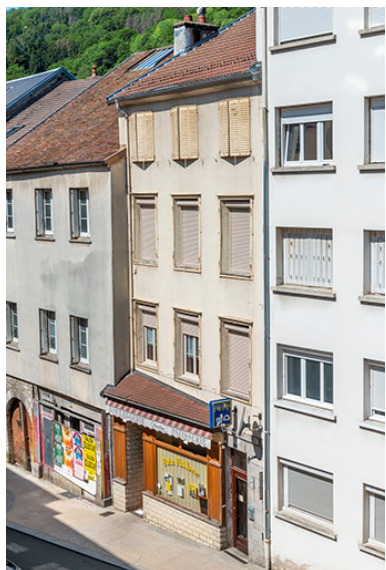
Façade est vue de trois quarts droite (rue de la Liberté). Phot. Jérôme Mongreville IVR43_20233900873NUC4A
