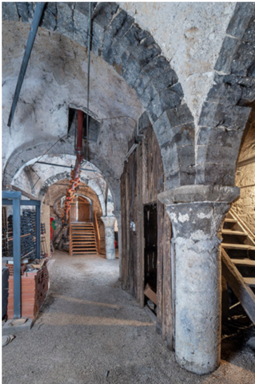
Vue d'ensemble de la cave, depuis l'est.
