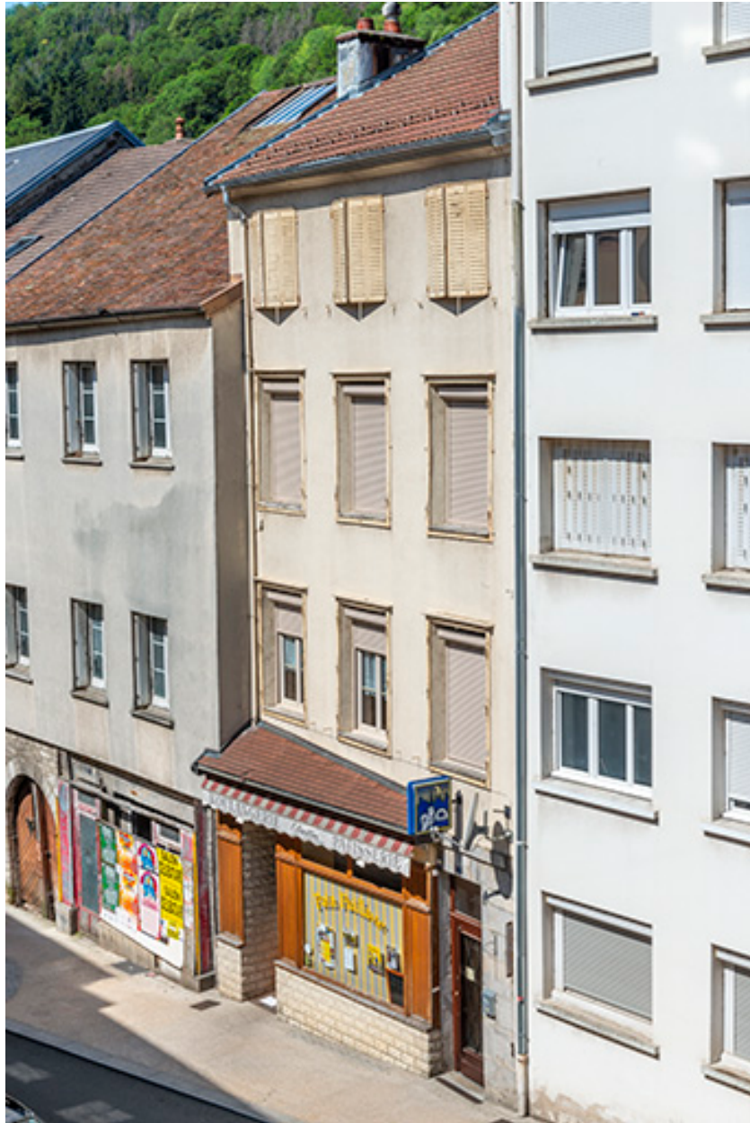
Façade est vue de trois quarts droite (rue de la Liberté).
