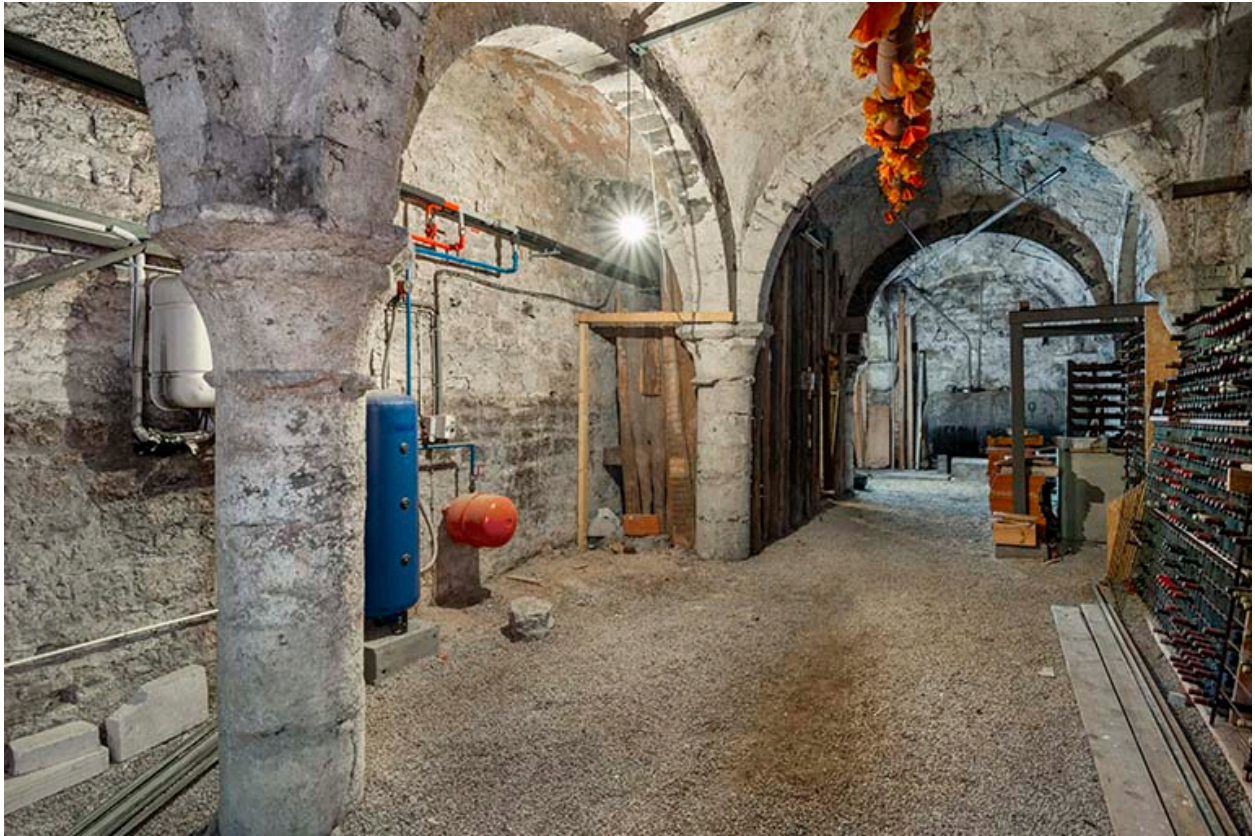
Cave vue de trois quarts, depuis l'ouest.
