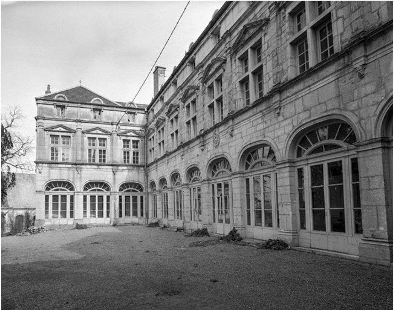
Façade sur cour : partie gauche.
