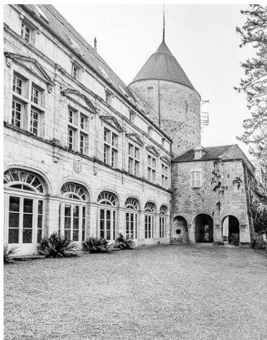
Façade sur cour : partie droite. Phot. Dominique Dominguez IVR43_19807000284X
