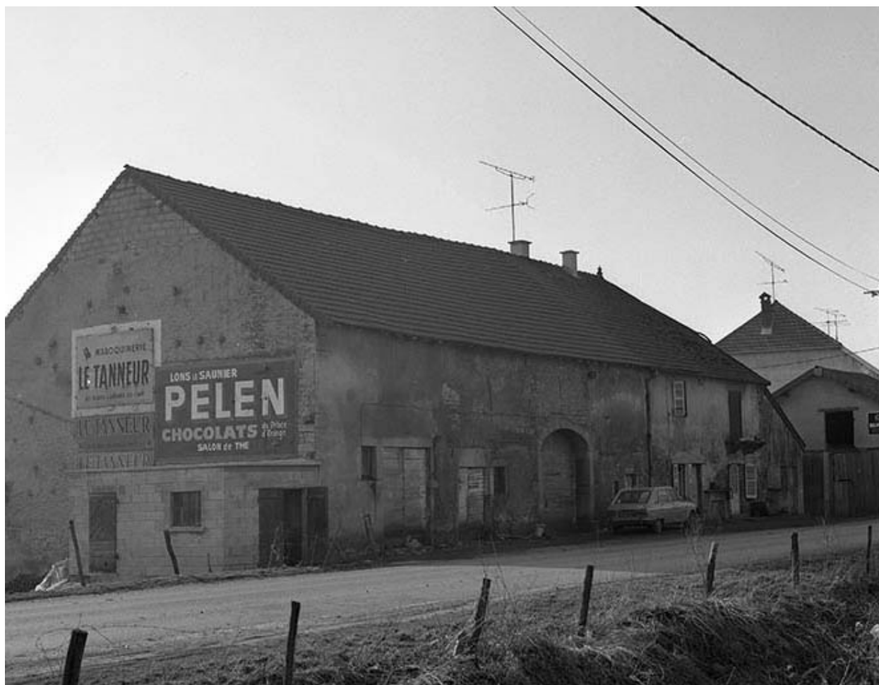
Façade antérieure et face gauche.
