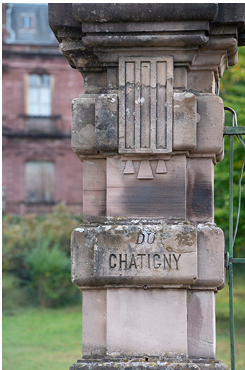
Portail de la clôture côté rue de Grammont, pilier.
