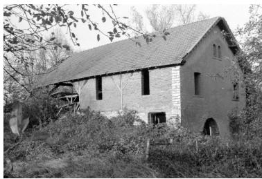
Atelier de fabrication, vu de trois quarts. Phot. Laurent Poupard IVR43_19883900711Z
