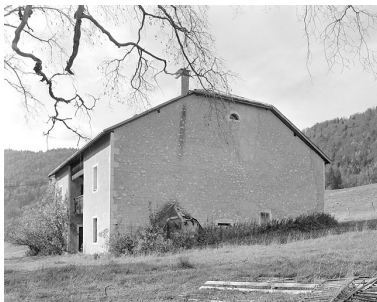
Face nord-est. Phot. Jérôme Mongreville IVR43_19963901520X
