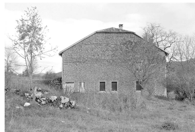
Face sud-ouest. Phot. Jérôme Mongreville IVR43_19963901518X
