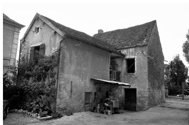
Vue d'ensemble. Phot. Bernard Lardière IVR43_19797000280Z
